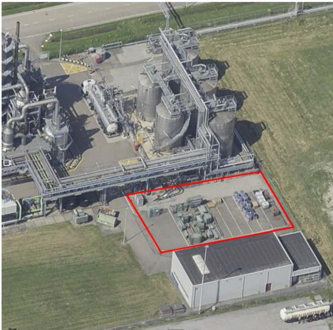
Figuur 2: overzichtsfoto. Links de bestaande fabriek, rechts boven het bestaande tankput, rood omlijnt de locatie voor de nieuwe tanks.
