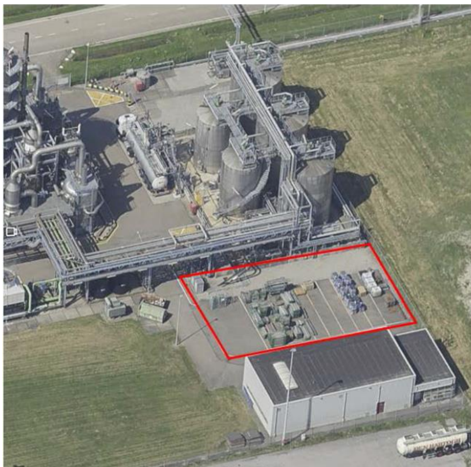
1: overzichtsfoto. Links de bestaande fabriek, boven de bestaande tankput, rood omlijnt de uitbreiding van de tankput voor 2 opslag tanks.
