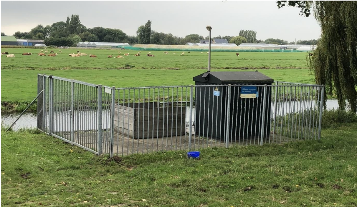
Afbeelding 5 Poldergemaal Noordeinde- en Geerpolder – huidige situatie
