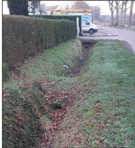
Foto links: A-watgang OVK04999 thv. lozingspunt HWA-stelsel Fort Pinsenweg Foto rechts: Dam met duiker welke is verzand.
