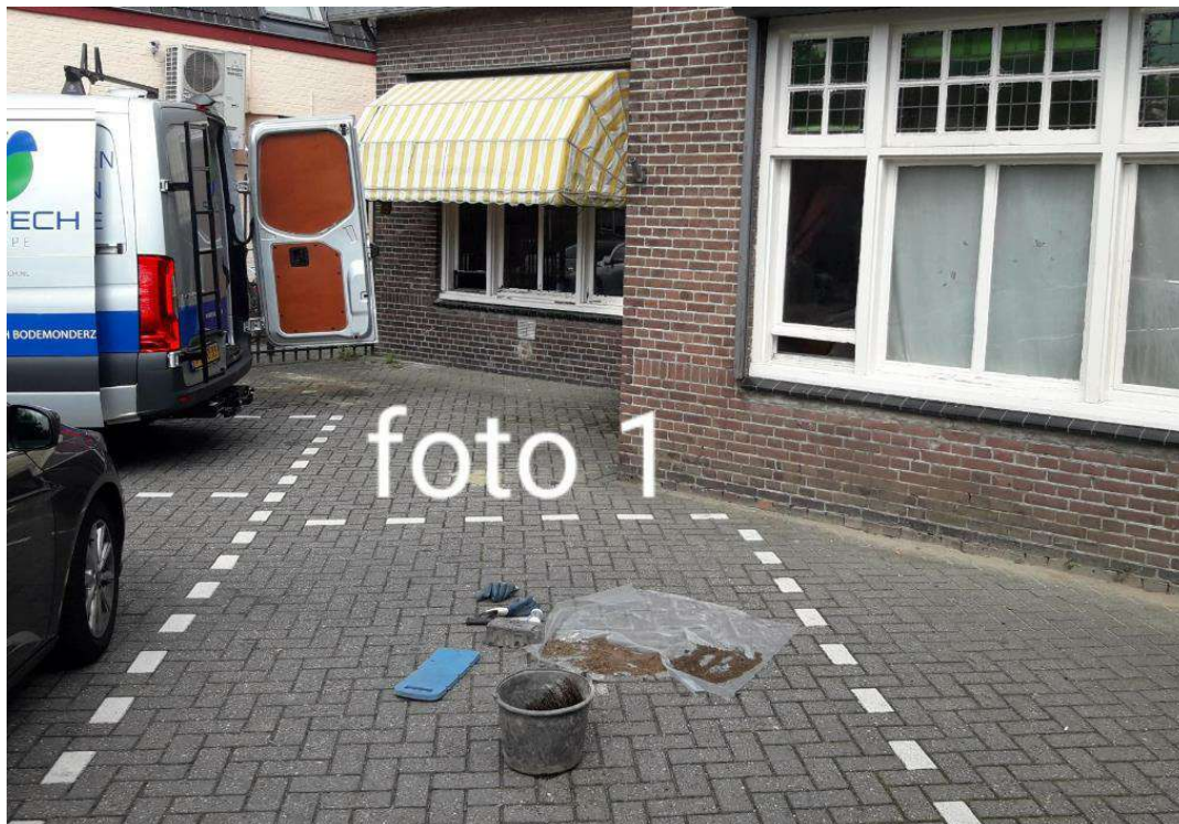
Foto 1: Boring 1 geplaatst aan de voorkant van de woning.
