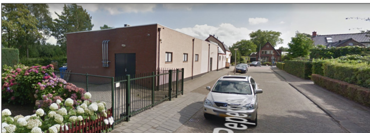
Figuur 2.2. Streetview beelden situatie vóór sloop woning Valdijk 27 (bron: Google Maps)
