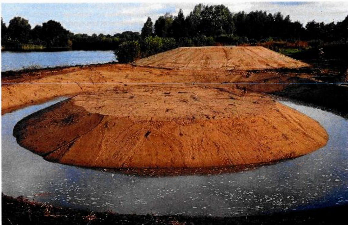
Figuur 4-5. Beoogde eindsituatie ter plaatse van compensatielocatie voor nieuwbouwlocatie Snellerpoort (excl. de stapel met grote stenen). Bovenstaande foto toont het eindresultaat van de gerealiseerde compensatie voor locatie Snellerpoort Roche (geel omlijnd in figuur 4-2).
