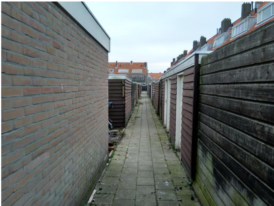
Foto 5: Brandgang zuidwestelijk gedeelte; foto in zuidelijke richting
