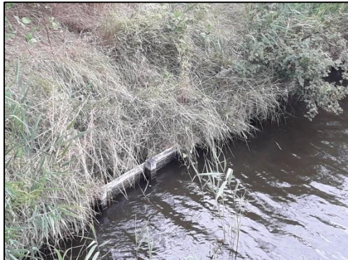
Figuur 9. Kunstmatige beschoeiing langs de watergang ten oosten van de onderzoekslocatie.
