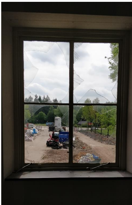
Foto 36: Voorbeeld van een kozijn wat oorspronkelijk is gebruikt.
