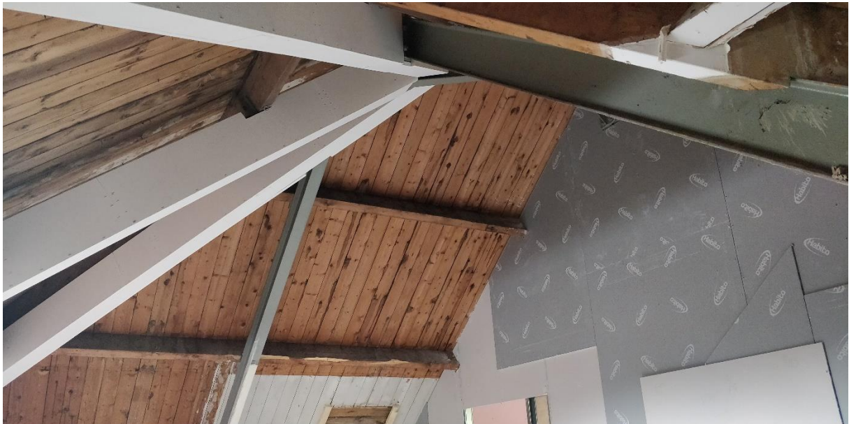
Foto 77: Dak aan de zijkant van het hoofdgebouw.
