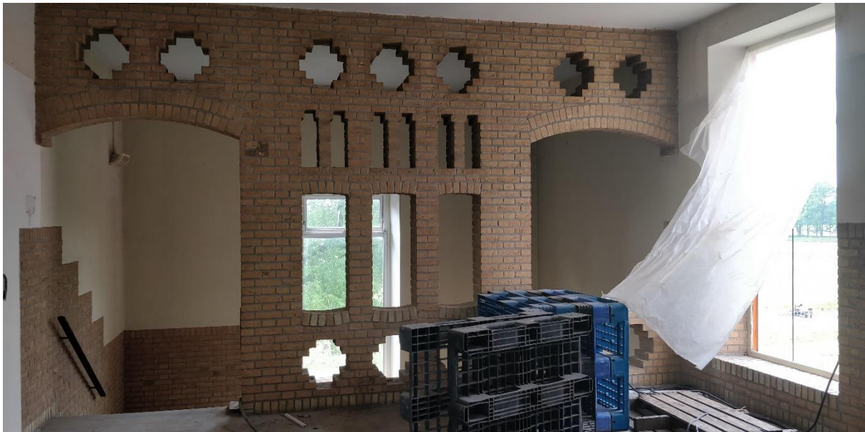
Foto 69: Constructie bij de trap.
