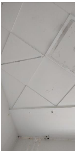
Foto 38: Het dak wat op meerdere plekken op de eerste verdieping terug komt.
