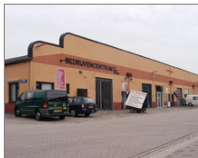
Verbeterde uitstraling door geschilderde gevel
