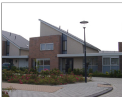
Woning in oostelijk deel van Kersenboogerd
