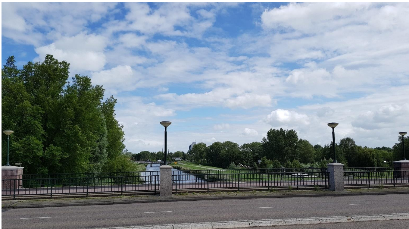
Waterlandbrug over Purnervaart met daarachter het Leeghwaterpark in de lager gelegen polder de Purmer (droogmakerij).
