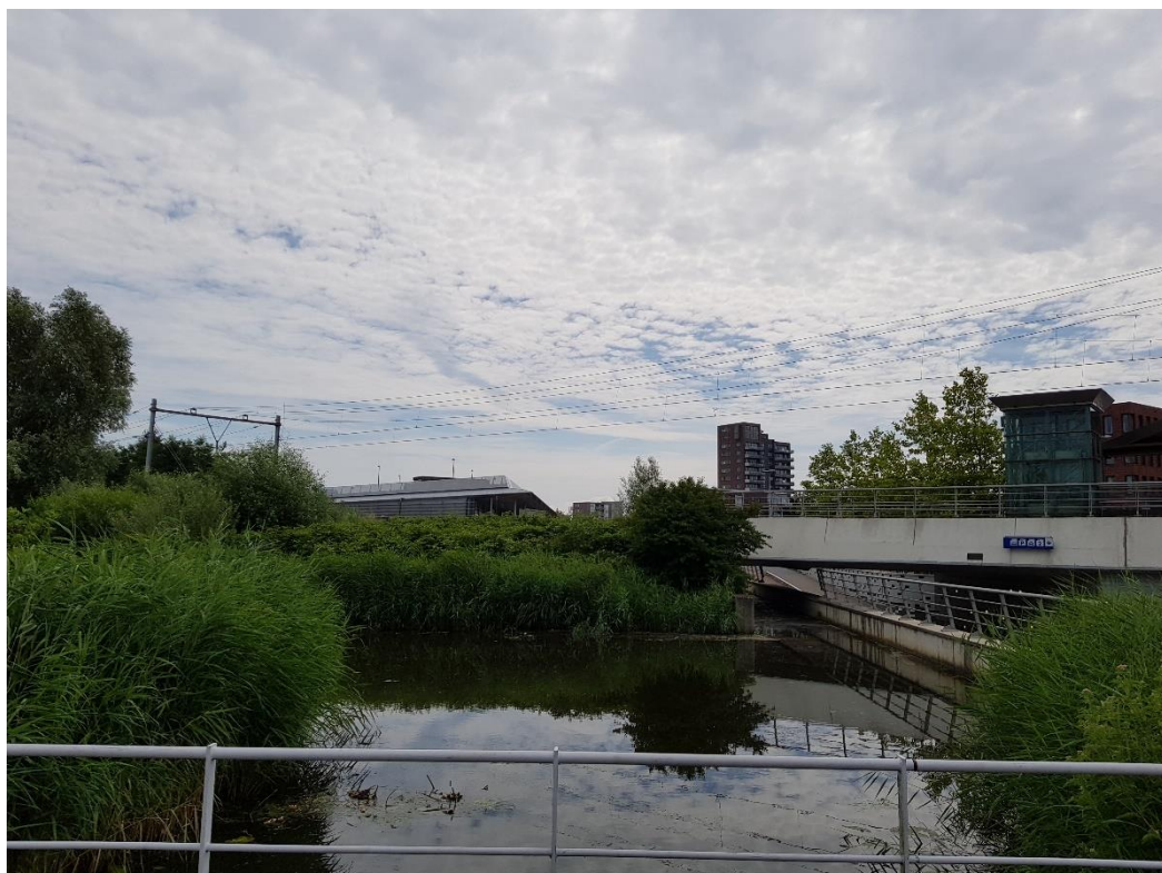
Spooronderdoorgang bij station Weidevenne.
