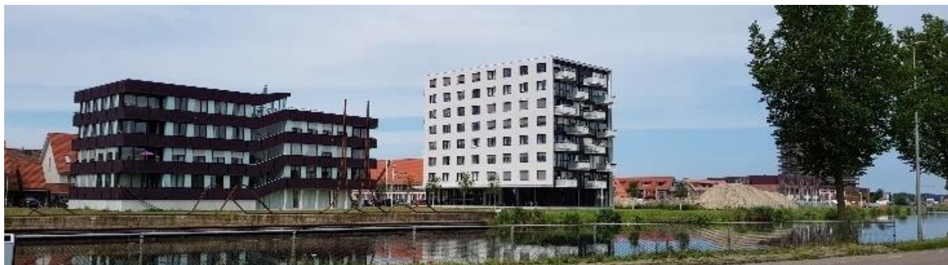
Woningbouw langs kanaal (Weidevenne)
