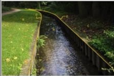
soort beschoeiing: paalschot materiaal: hardhout functie: kerende functie
