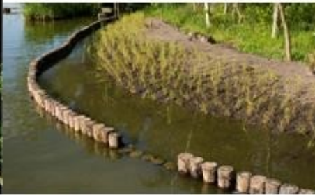
Soort beschoeiing: palenrijbeschoeiing functie: behoud doorstroomprofiel
