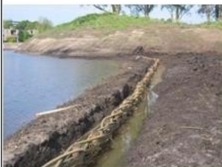
soort beschoeiing: paalwiepenbeschoeiing functie: tijdelijk behoud doorstroomprofiel
