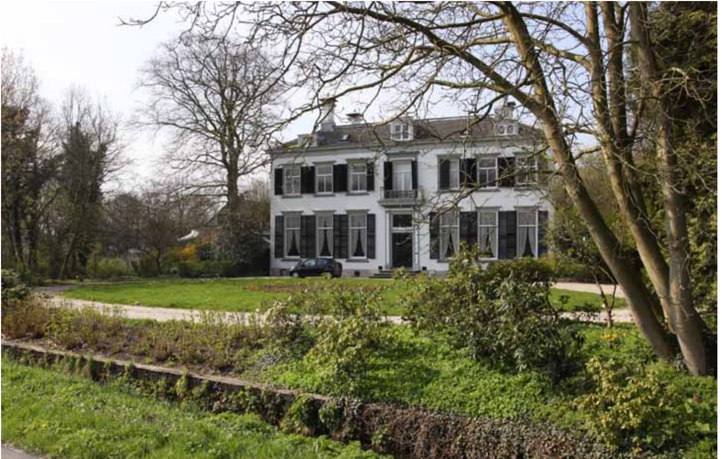
KLASSIEK BUITENPLAATS HERTEVELD MET KENMERKENDE ARCHITECTUUR EN ELEMENTEN ALS DAKPANBESCHOEIING LANGS DE WATERGANG
