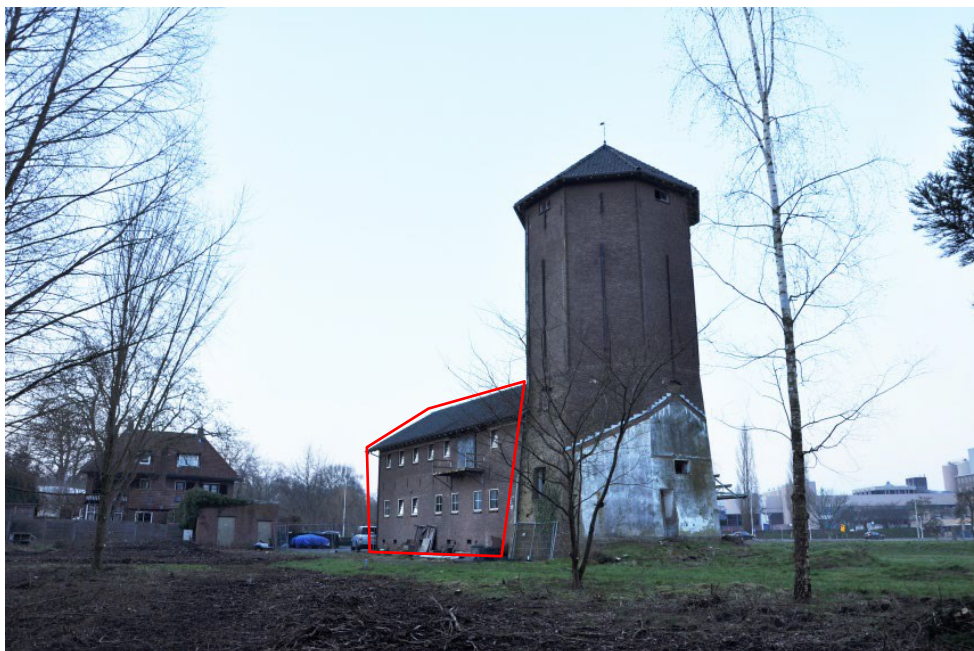
Figuur 2: Te slopen bebouwing, links (rood omlijnd) de aanbouw, rechts de silotoren (Bron: Vervolgonderzoek Graaf Ottoweg Lochem; Jansen & Jansen Groenadviesbureau, 2018)
