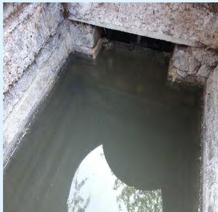
opgeboeid riool Van Swietenstraat/ Van Beveringhlaan, foto: Wareco
