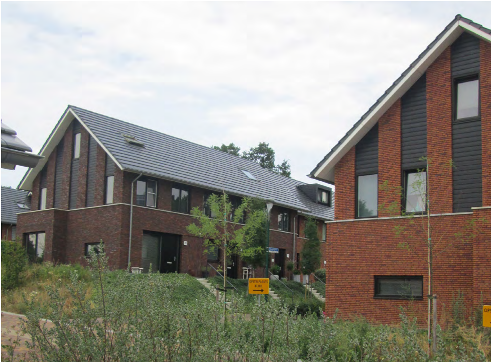
Kopgevels gericht op het groen
