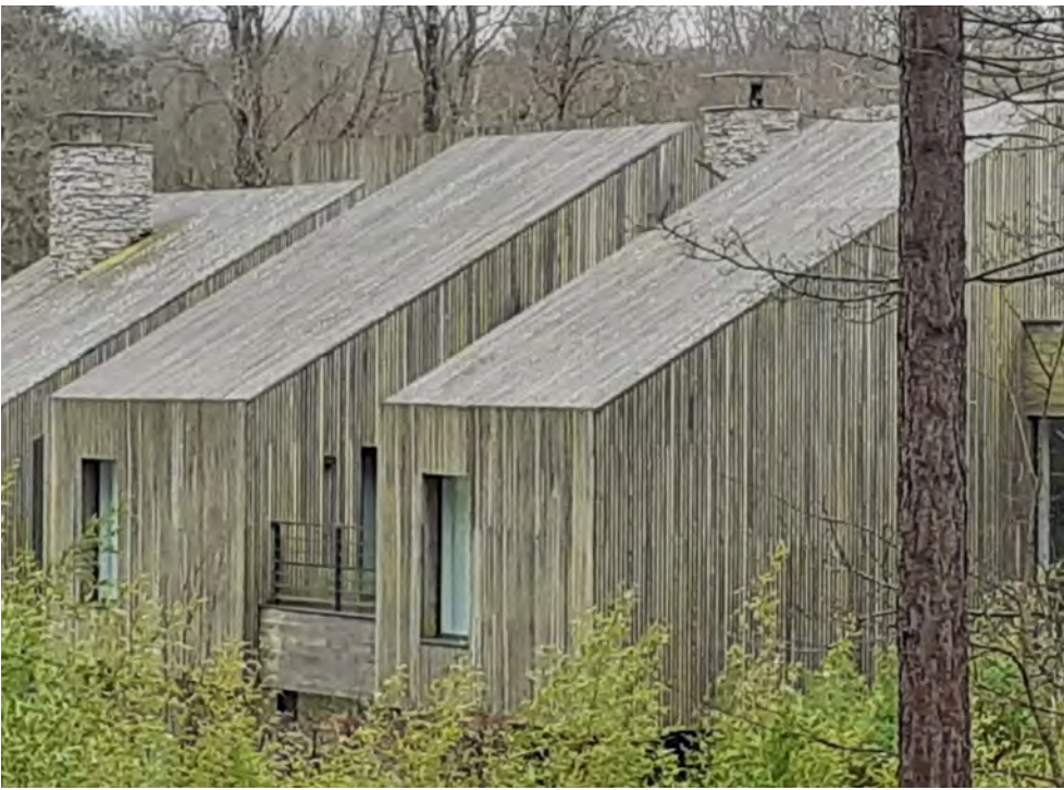
Ruim toegepast houten materiaal
