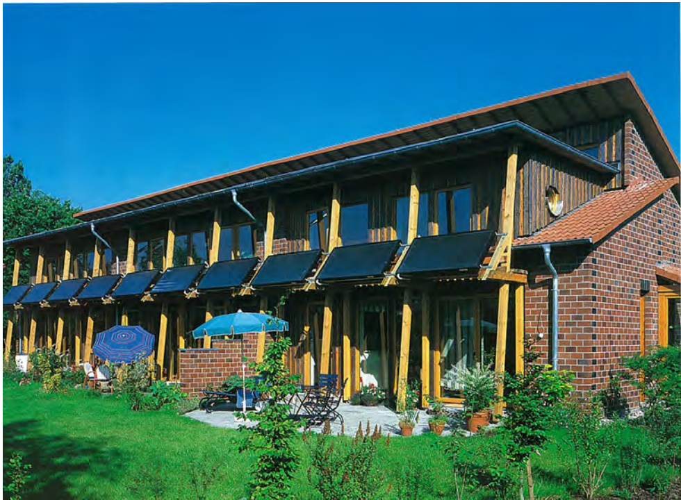
De zonnepanelen zijn niet in het dak opgenomen maar zijn onderdeel van de architectonische vormgeving
