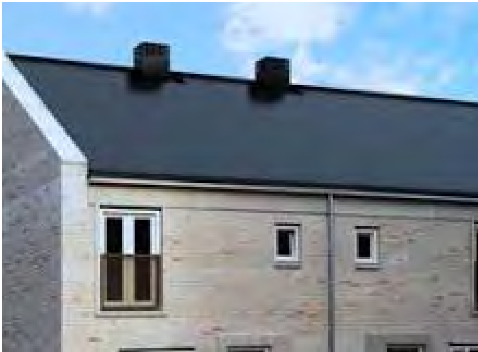
Luchtwarmtepompen pijpen in één schoorsteen
