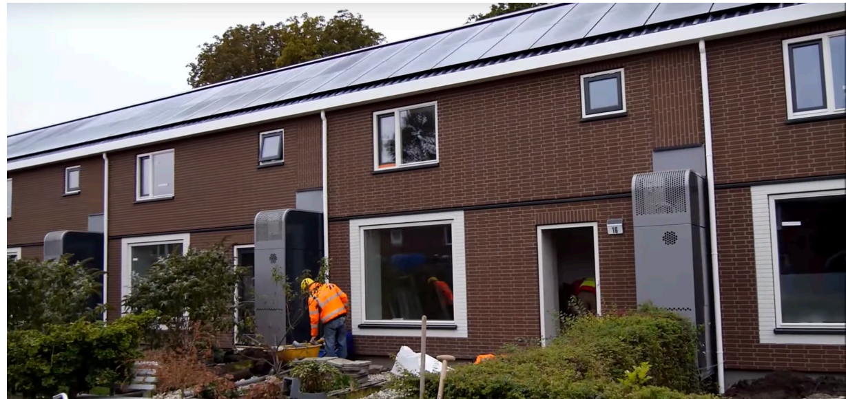
Transformatie bestaande woningen naar nul-op-de-meter in Rutten
