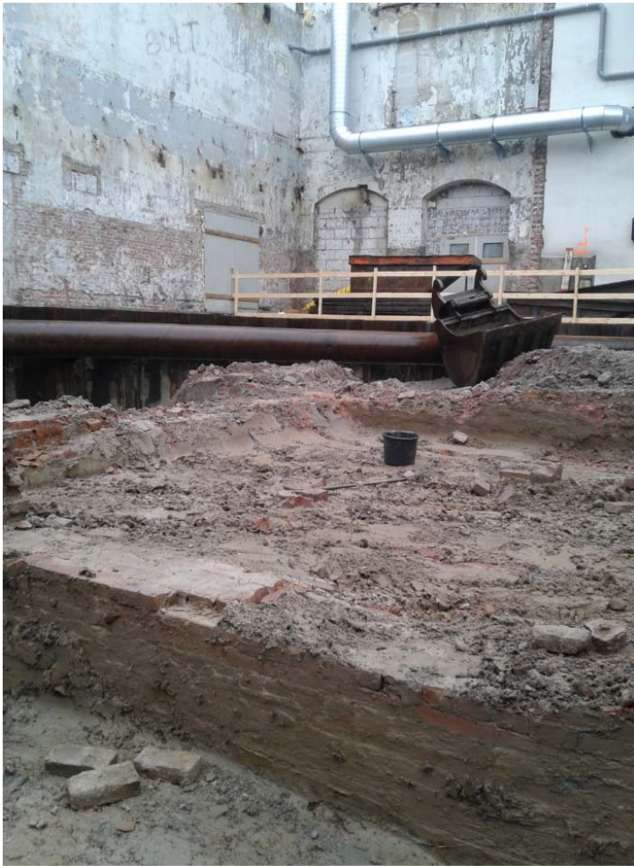
Ontgraven sterk verontreinigde bovengrond (maart 2020) Vak 2 tussen oude kelder en nieuw kelder (putbodem voorafgaande aan uitkeuring)
