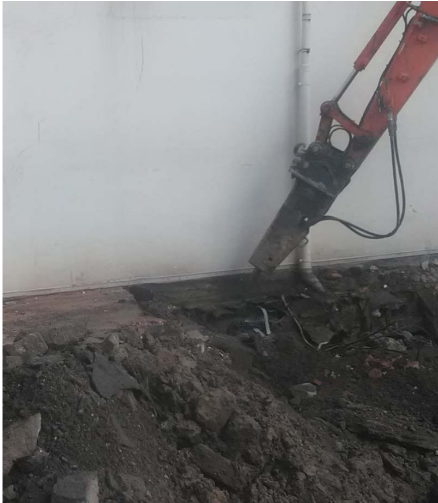
Detail ontgraving strook langs gebouw(puin en funderingen)
