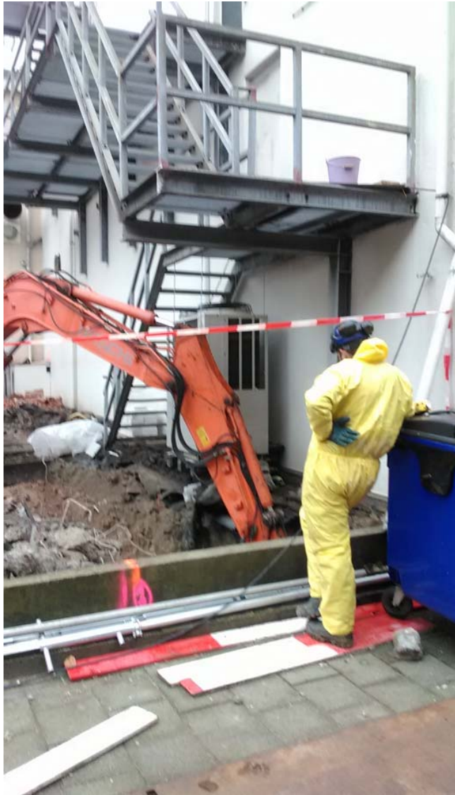
Fase 1 (nov. 2019) plaatsen vetvangput voor restaurant
