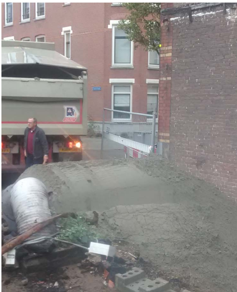
Tijdelijke aanvulling tankgat met plaatselijke grond t.b.v. plaatsen damwand.
