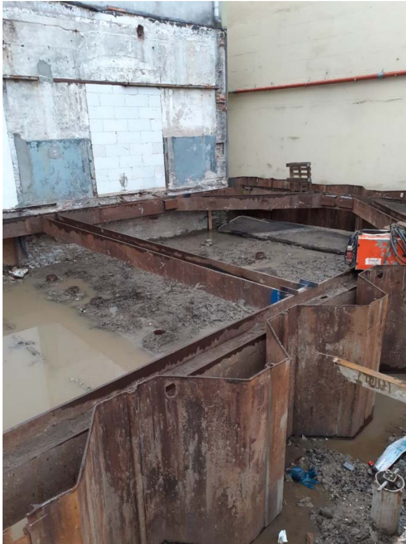
Fase 2 sanering Aanvang ontgraving industriegrond langs Maaskade
