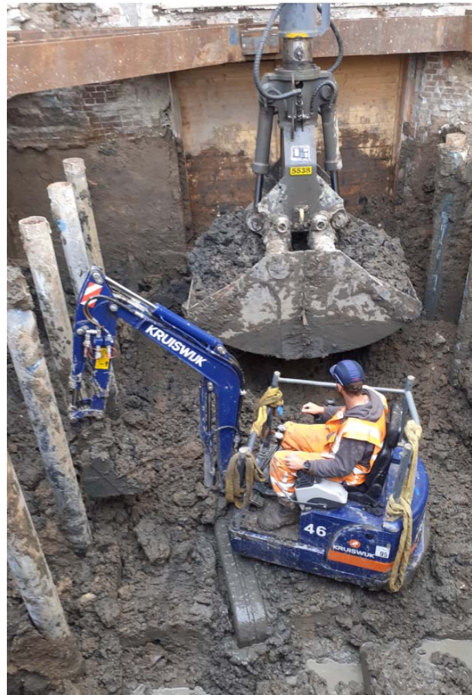
Fase 2 sanering Ontgraving industriegrond langs Maaskade
