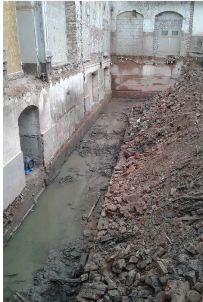
Vrij gegraven stook buiten kelder t.b.v. plaatsen damwand strook aan noordzijde t.b.v uitkeuring ontgraving sterk verontreinigde grond (voor zover aanwezig tussen het puin en funderingen)
