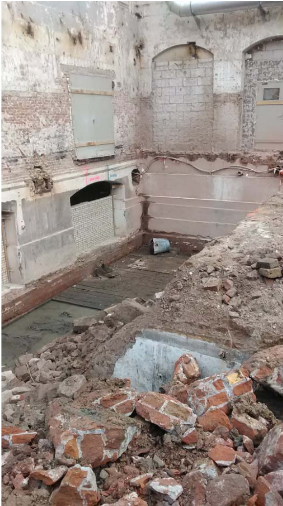
Sloop funderingen en kelder t.b.v. plaatsen damwand Detail: houten basisfundering op klei-ondergrond
