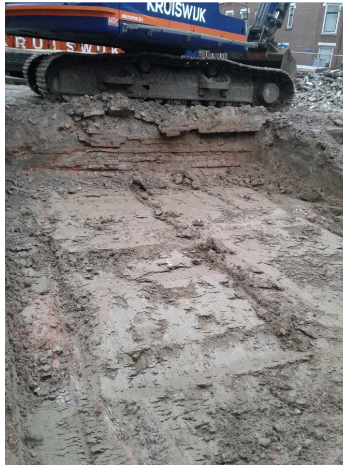
Ontgraven sterk verontreinigde bovengrond (maart 2020) Vak 2 tussen oude kelder en nieuw kelder (detail putbodem voorafgaande aan uitkeuring)
