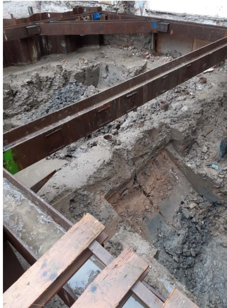
Fase 2 sanering Ontgraving industriegrond langs Maaskade
