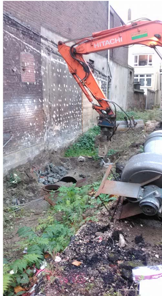
sanering aanwezige tank (nov 2019): blootgraven tank
