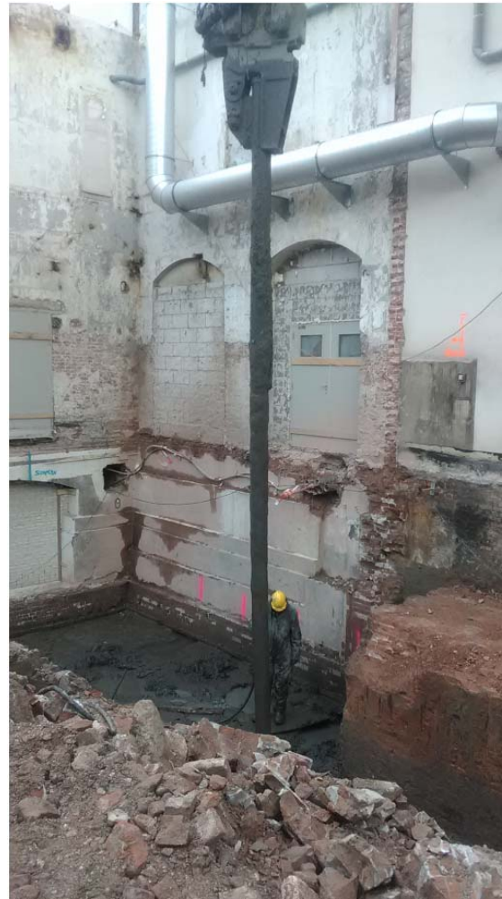
trekken houten funderingspalen van oude funderingen
