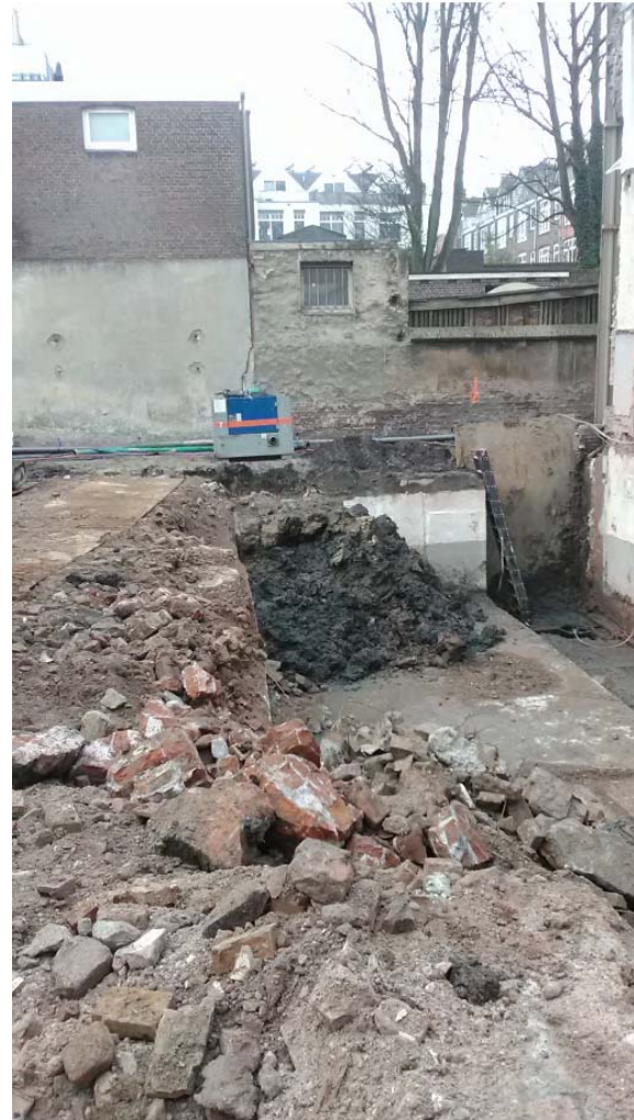
Sloop funderingen en kelder t.b.v. plaatsen damwand gezien in de richting van Hoffmanstraat 17
