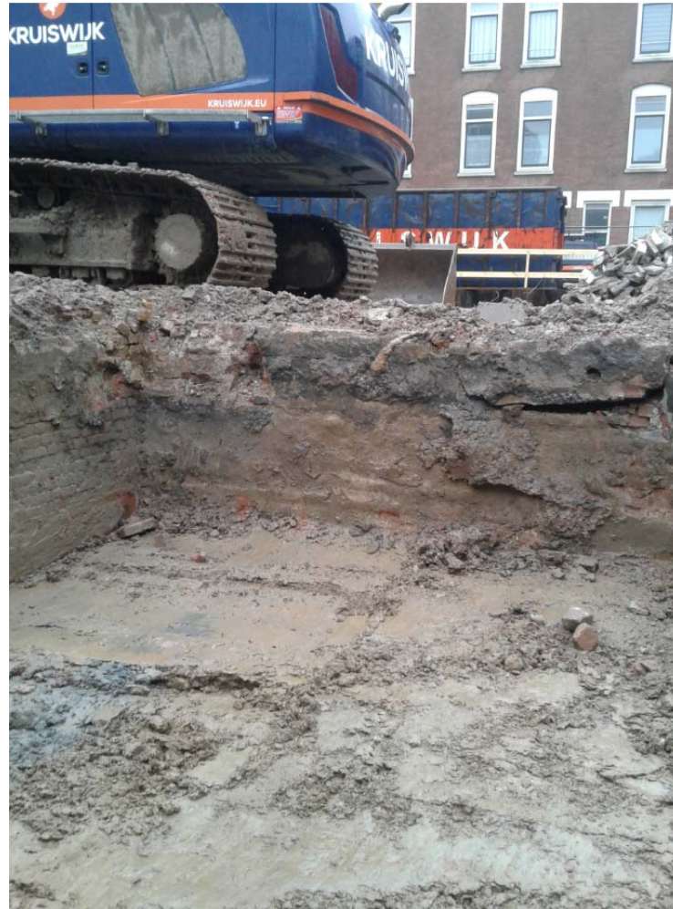
Ontgraven sterk verontreinigde bovengrond (maart 2020)
