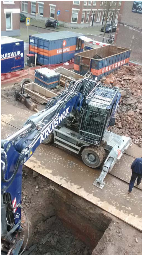
Ontgraving puin en funderingen
