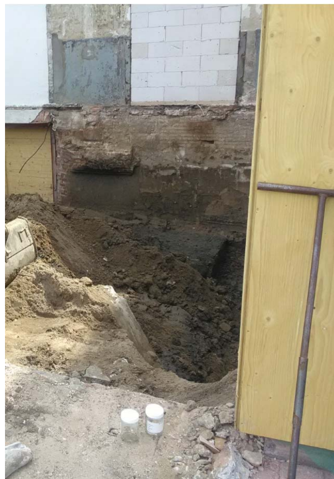
Fase 2 sanering: sloop gebouwen en fundering langs Maaskade
