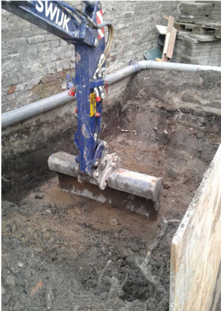
Ontgraven ernstig verontreinigde bovengrond Steeg tussen Hoffmanstraat 15 en 17
