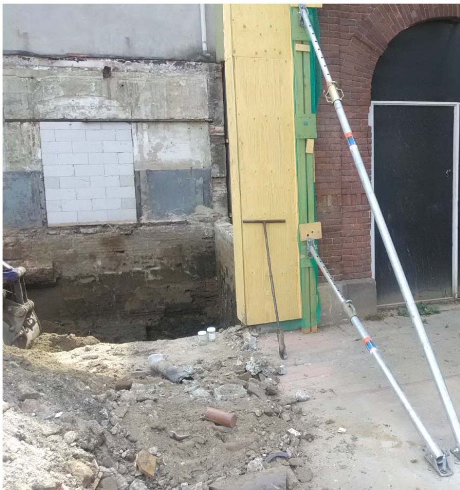
Fase 2 sanering: sloop gebouwen en fundering langs Maaskade
