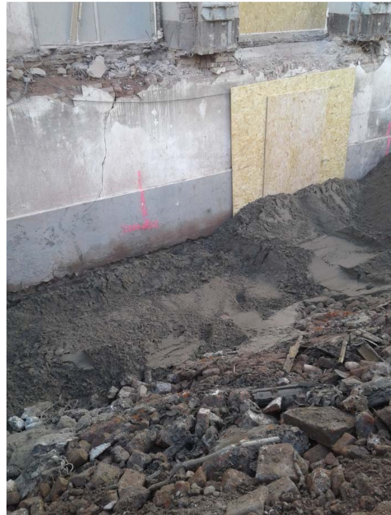
Aanvullen ontgraven stroken met schoon zand t.b.v. Plaatsen damwandstelling
