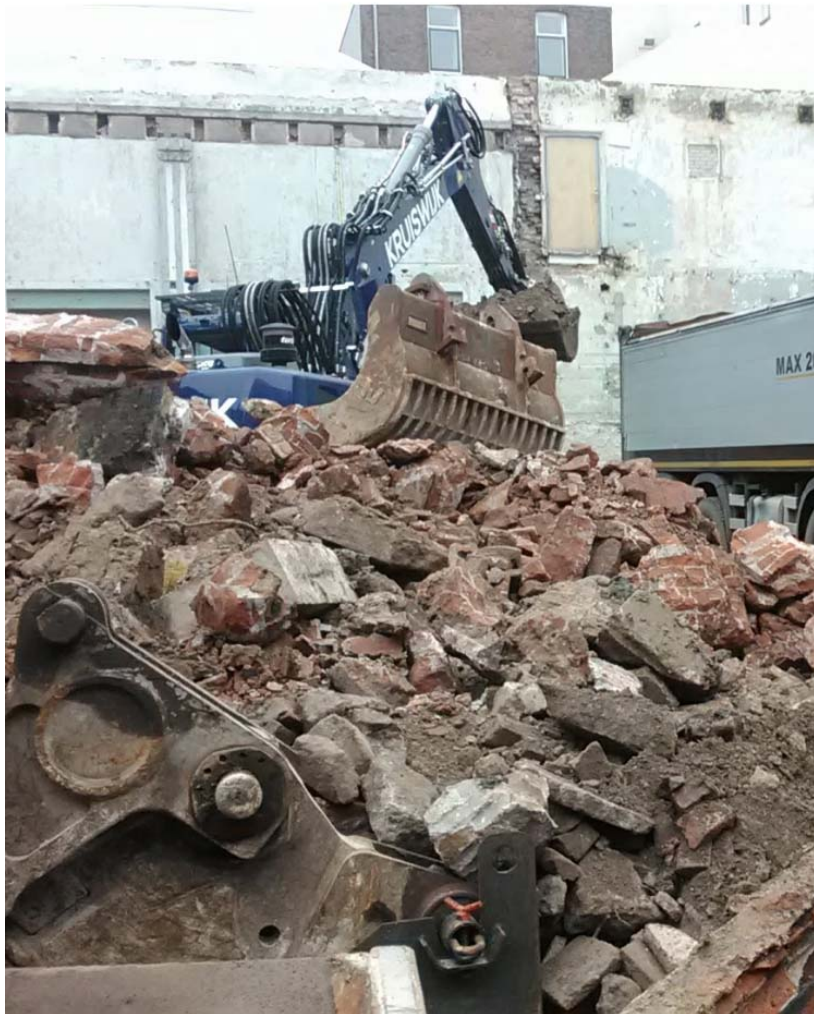
Afvoer vrijkomend puin uit sloop funderingen en kelder
