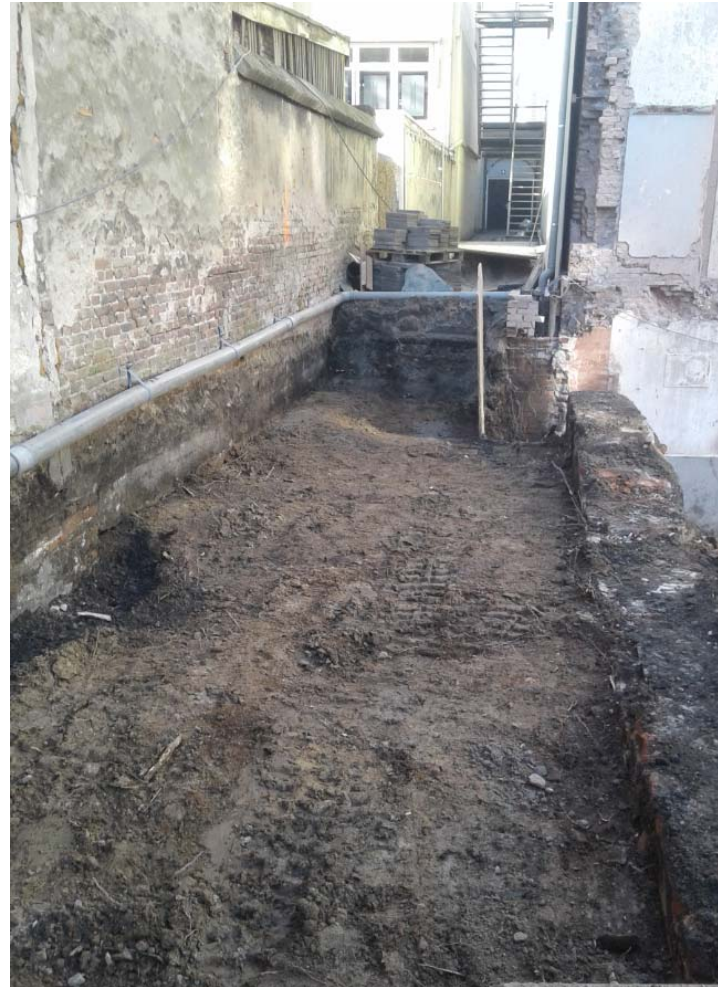
Ontgraven ernstig verontreinigde bovengrond Steeg tussen Hoffmanstraat 15 en 17
