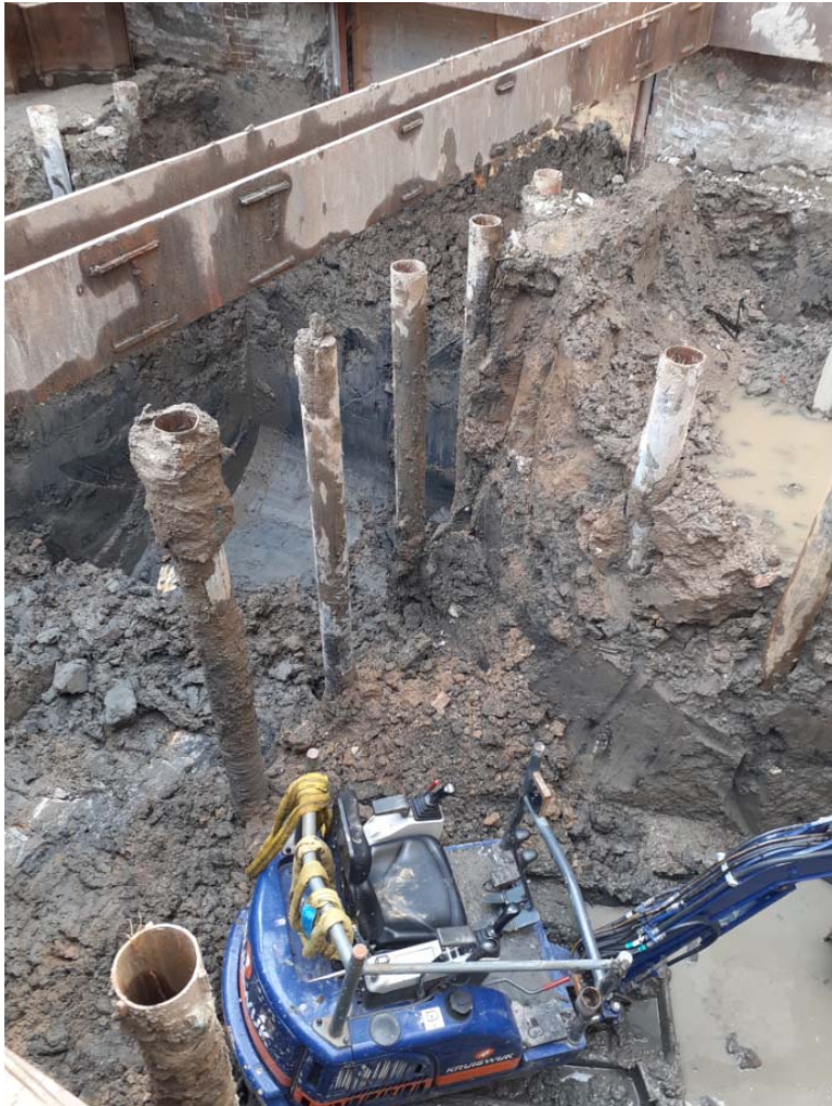
Fase 2 sanering Ontgraving industriegrond langs Maaskade
