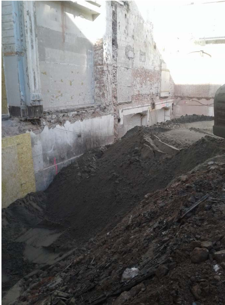
Aanvullen ontgraven stroken met schoon zand t.b.v. Plaatsen damwandstelling
