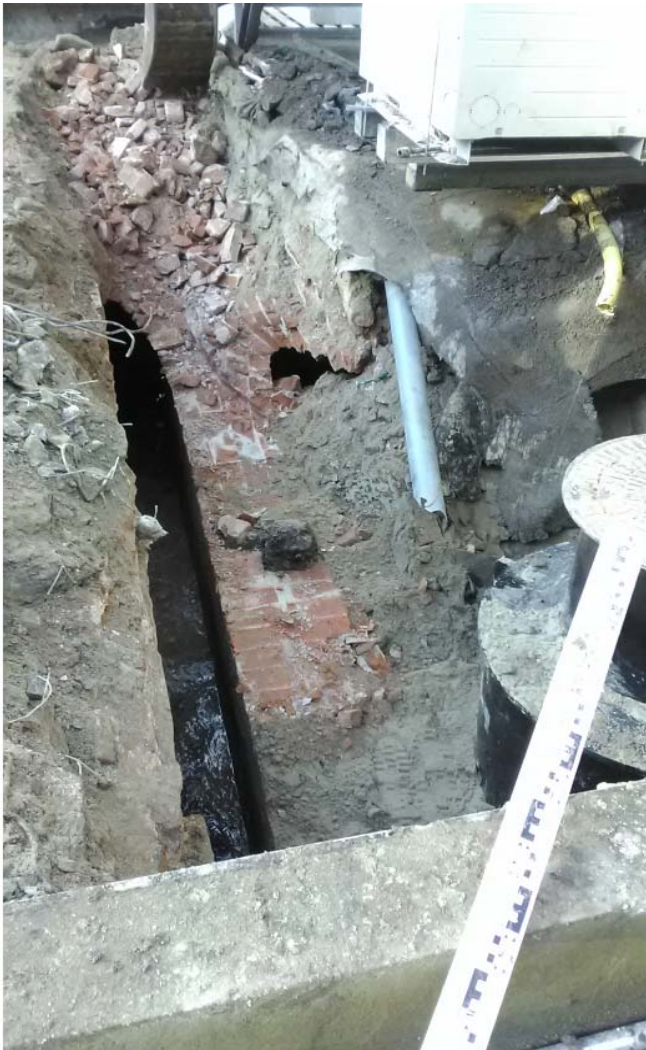
Ontgraven strook langs gebouw: puin en funderingen
