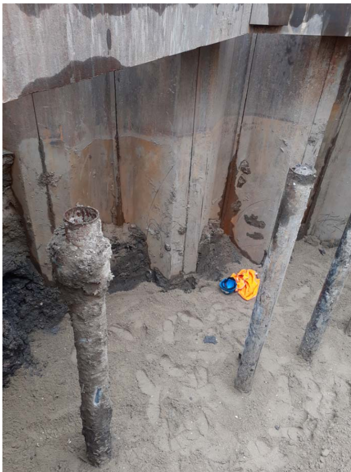
Fase 2 Gedeeltelijke aanvulling met zand en drain t.b.v. grondverbetering
