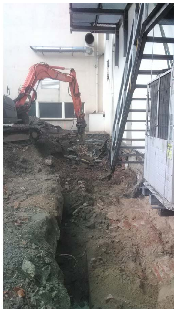
Verdere ontgraving strook lang gebouw t.b.v. Plaatsen damwand: puin en funderingen
