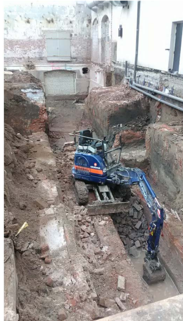
ontgraving langs gebouw t.b.v. plaatsen damwand Verwijdering puin en funderingen
