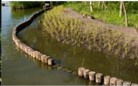
Soort beschoeiing: palenrijbeschoeiing functie: behoud doorstroomprofiel
