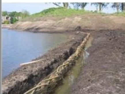
soort beschoeiing: paalwiepenbeschoeiing functie: tijdelijk behoud doorstroomprofiel
