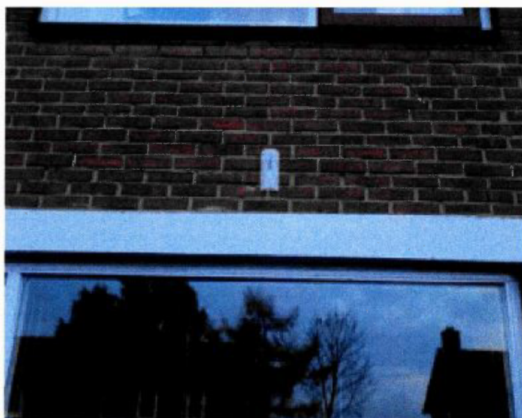
Stootvoegen afgesloten met een exclusion flap en bijenbekjes.
