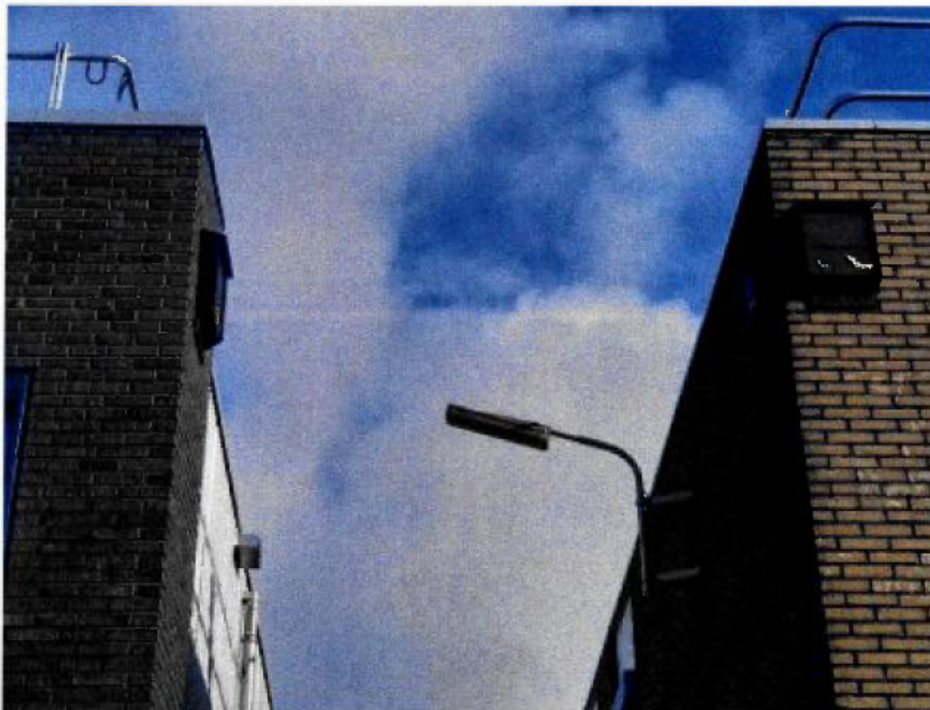
Figuur 5. Impressie van de drie geplaatste vleermuizenkasten op de gebouwen van de Ambachtstraat 4 en 6. De verlichting nabij de kasten is niet werking.
