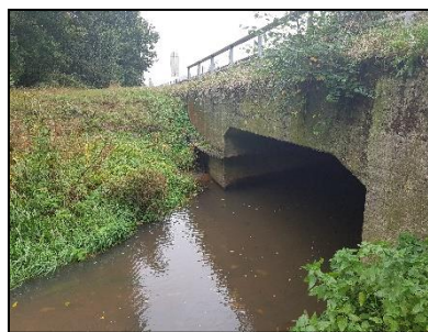
Figuur 2. Duiker met faunapassage onder A73.
