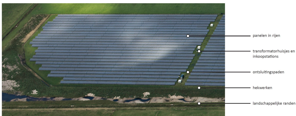
ELEMENTEN VAN EEN ZONNEPARK
