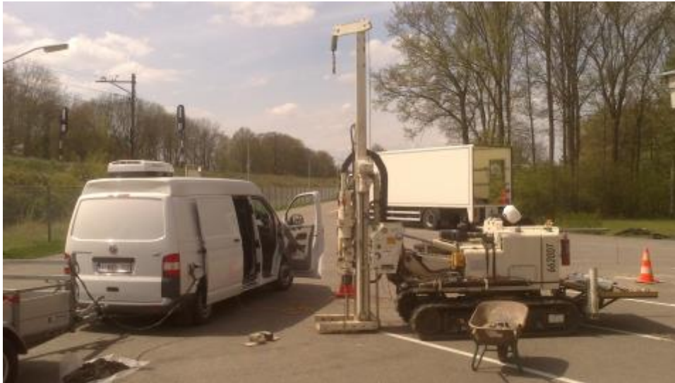
Afbeelding 3.1 De uitvoering van een Enissa-sondering op een willekeurige locatie in Nederland
