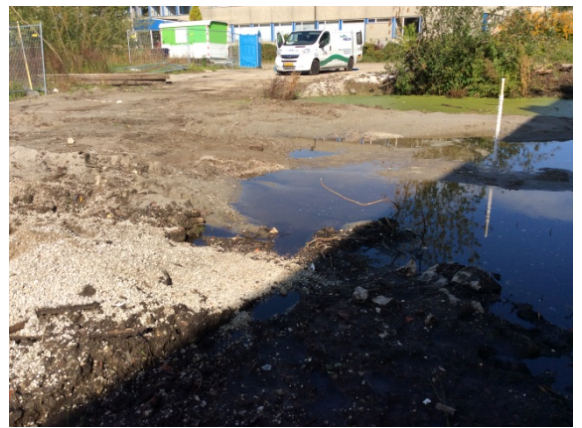
Foto 4: Overzicht vanaf Kanaalweg
