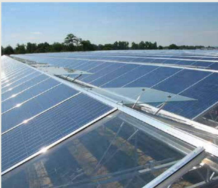
De nokrichting is gedraaid voor toepassing zonnepanelen
