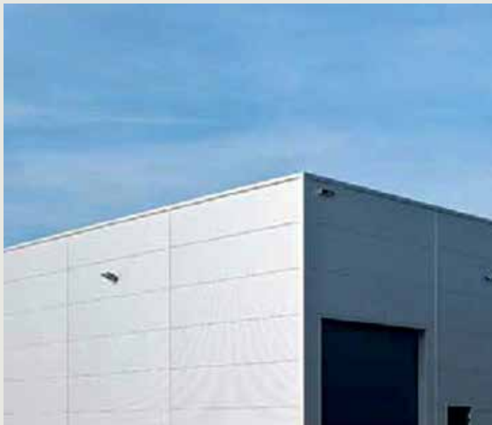
Aansluiting in kleur bij de omliggende kasbebauwing
