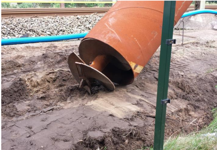
Boor in buis principe
