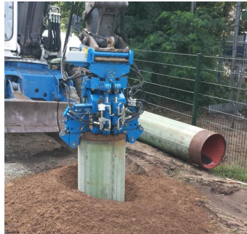
Borging buispaal (geklemd in de kop)
