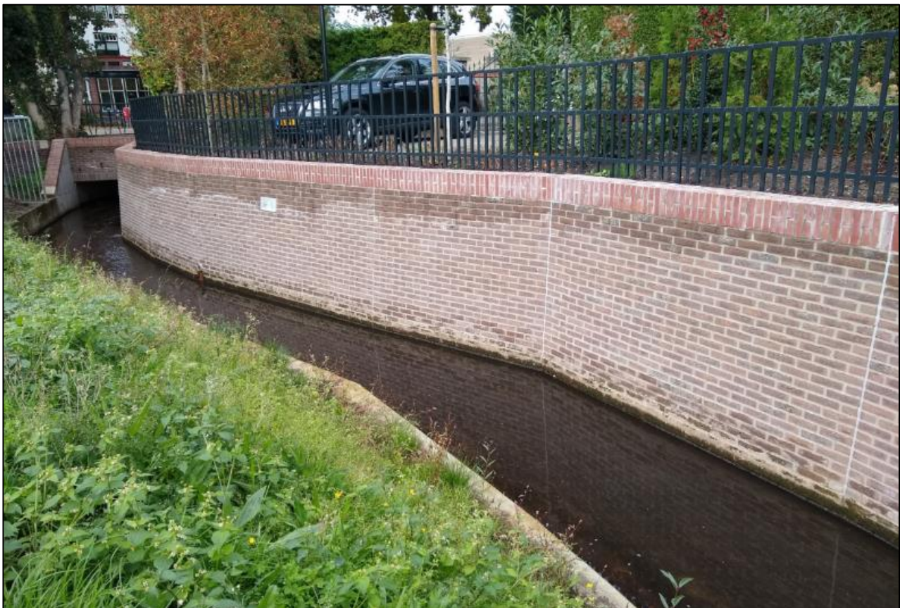
Figuur 16: voorbeeld grondkerende constructie (kademuur)
