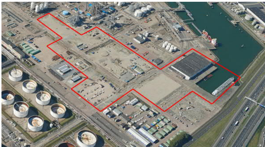
Figuur 1: Luchtfoto van het deel van het terrein van Shell Pernis waar de nieuwe fabriek zal worden gerealiseerd (rood omkaderd)
