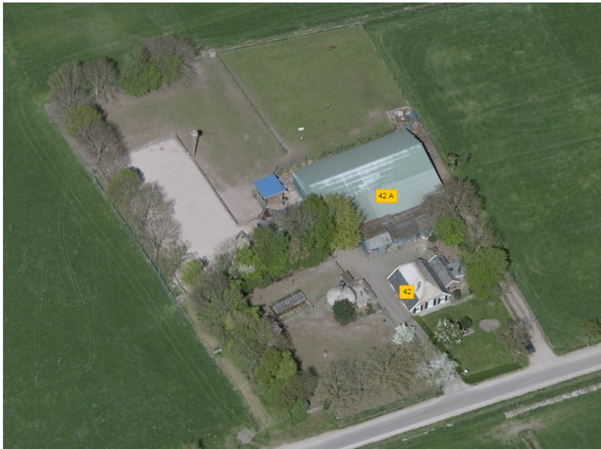
Afbeelding 3 - Luchtfoto bestaand erf
