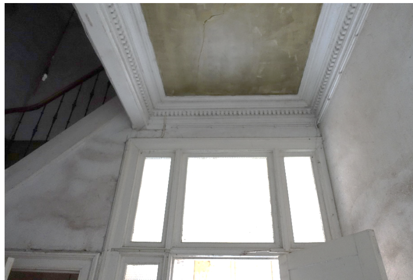
Afbeelding 21. De pui tussen vestibule en trappenhuis en het stucplafond met tandlijst van het trappenhuis. Het geheel is oorspronkelijk.
