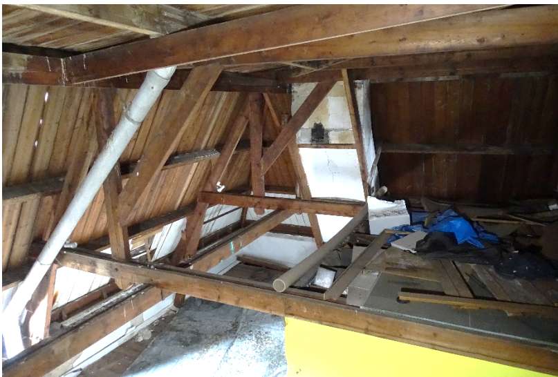
Afbeelding 18. De kapconstructie aan de rechterzijde van de achtergevel. De constructie is geheel oorspronkelijk en past goed bij de bouwperiode.
