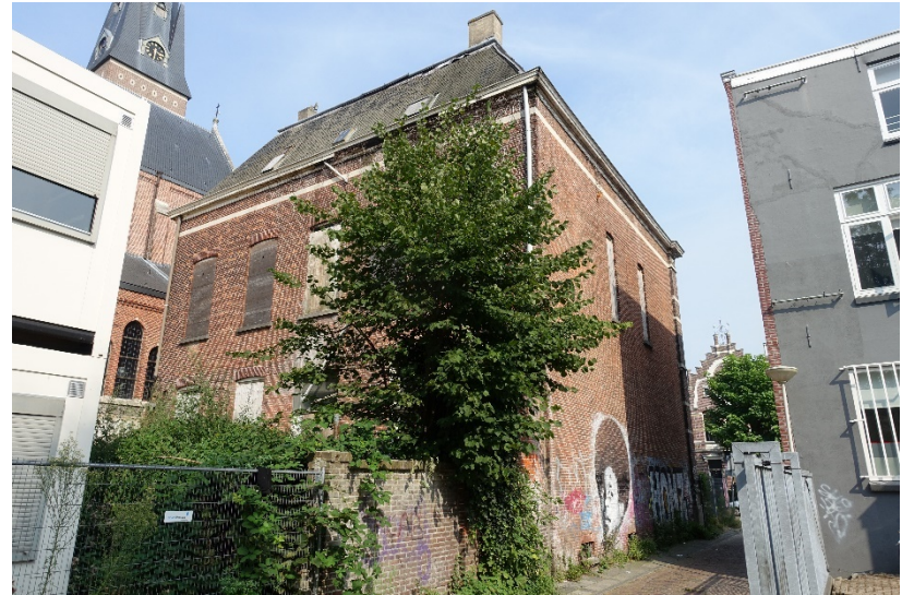
Afbeelding 17. De pastorie gezien vanuit het Van Almondepad. De zijgevel is zeer sober ingedeeld. De achtergevel is eenvoudiger vormgegeven dan de voorgevel en is symmetrisch ingedeeld.
