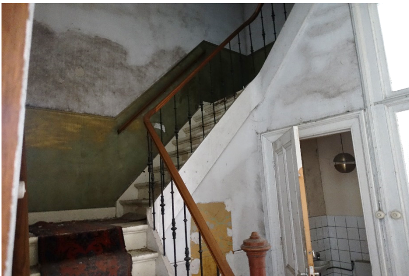
Afbeelding 20. Het trappenhuis op de begane grond. Het toilet is in de gang die naar de kerk leidde geplaatst, kozijn en deur zijn oorspronkelijk.
