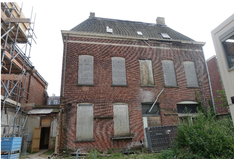
Afbeelding 6. De achtergevel van de pastorie. De indeling is geheel oorspronkelijk. De ornamentering is veel eenvoudiger dan bij de voorgevel.
