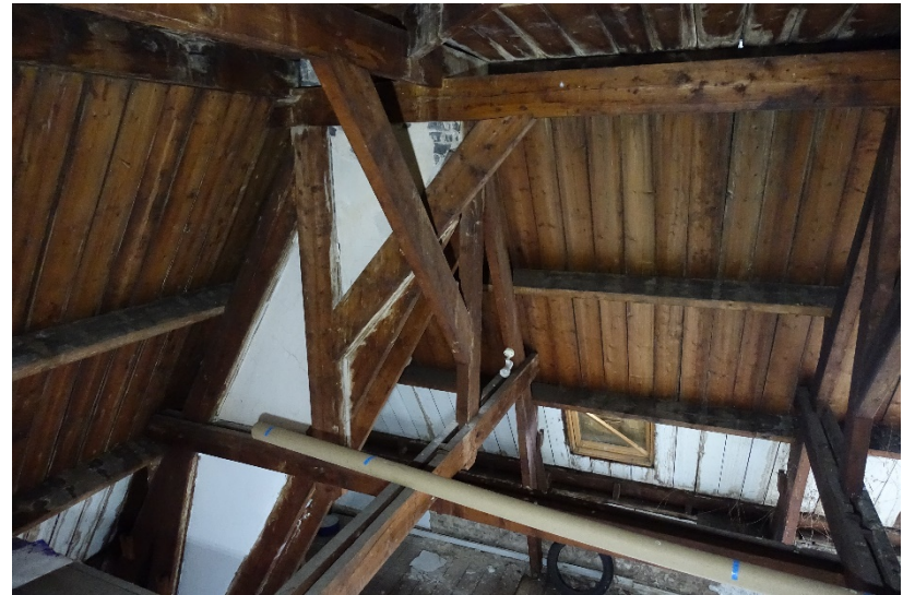
Afbeelding 5. De kapconstructie in de linker achterhoek. De dekbalken worden ondersteund door een stijl met korbeel die op de dubbele trekbalke staat.
