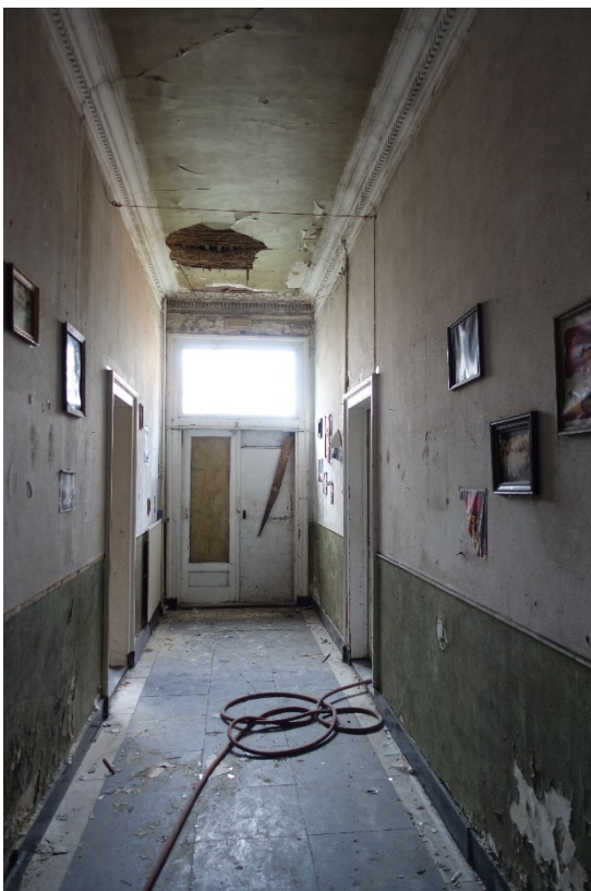
Afbeelding 8. De centrale gang na het trappenhuis in de richting van de achtergevel. De gang is symmetrisch opgezet. Ondanks alle schades is vrijwel al het oorspronkelijke materiaal en de afwerking er van nog aanwezig.
