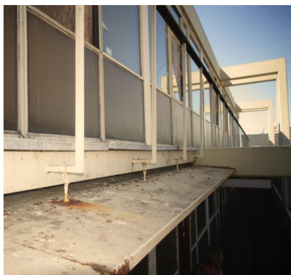
De stalen luifel met onderhoudsbrug bij de galerij. FH MAB
