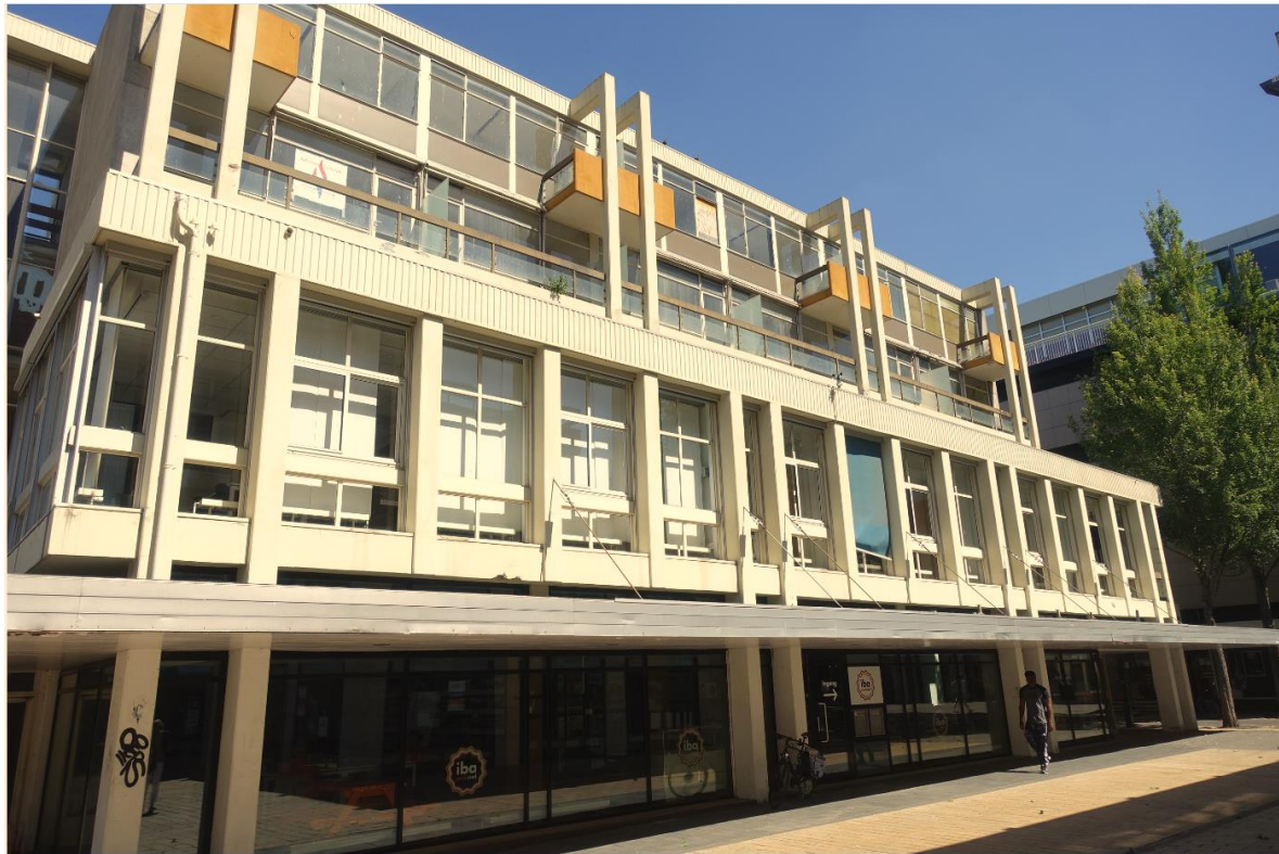
De rechter zijde van de voorgevel (linksboven), de linker zijde van de voorgevel met de entree en trappenhuis van de maisonnettes (rechtsboven) en overzicht van de voorgevel (onder) . Foto's Frank Haans MAB 29 mei 2020
