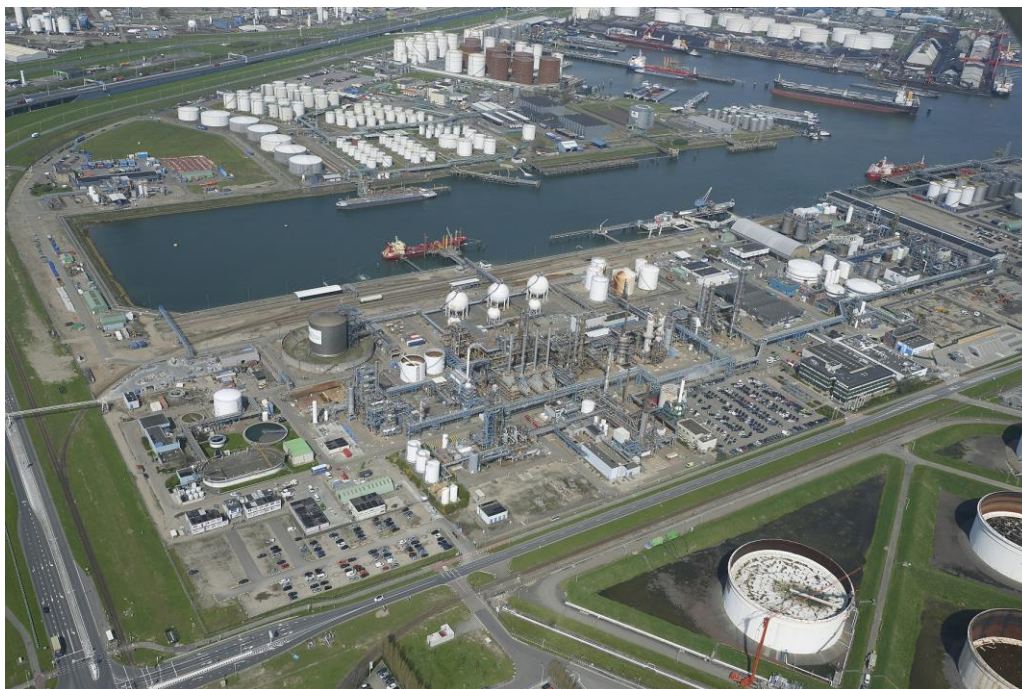
Figuur 1.1 Overzicht Bedrijvenpark Botlek met op de voorgrond de BIOBOT en de installaties van Shin-Etsu.
