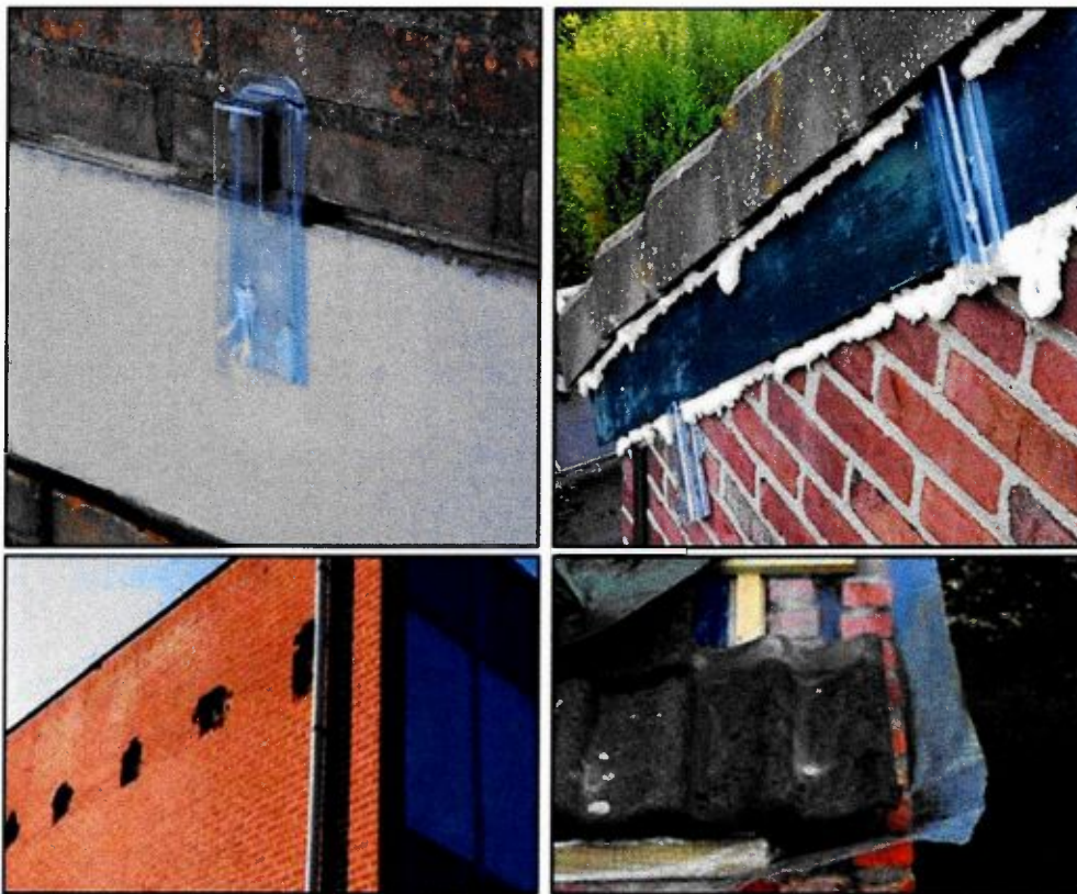
Figuur 3.1 Het ongeschikt maken van een vleermuisverblijfplaats kan op verschillende manieren. Voor de sloop, buiten de kritische periode, dienen de gevels ongeschikt gemaakt te worden.
