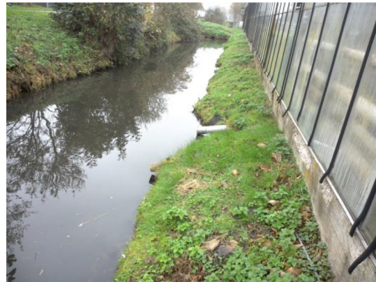
Foto 54. Asbesthoudende buismateriaal (bron Bron15)
