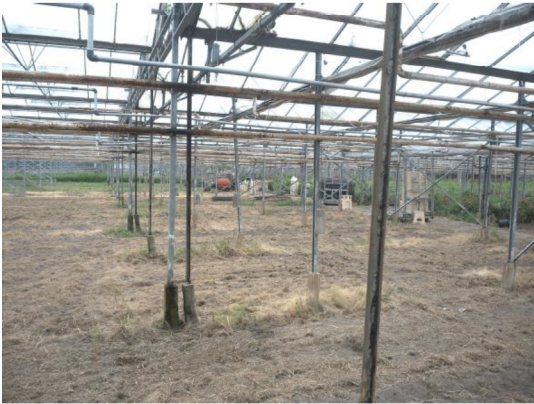
Foto 27. Asbesthoudende kaskit op gevel (bron Bron8)
