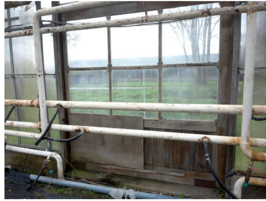
Foto 50. Asbesthoudende beglazingskit (bron Bron13)
