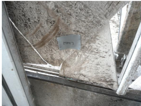
Foto 18. Niet-asbesthoudende plaatmateriaal (bron Bron5)
