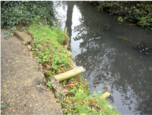
Foto 57. Asbesthoudende buismateriaal (bron Bron15)
