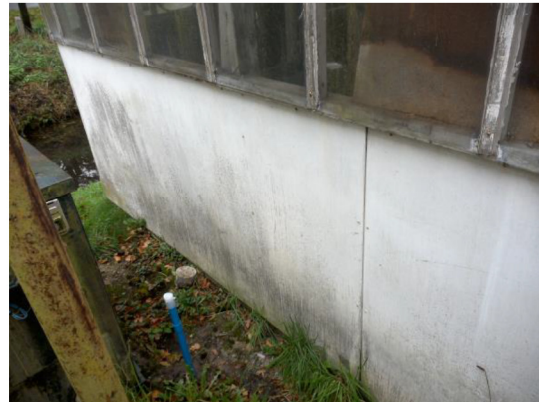
Foto 34. Asbesthoudende plaatmateriaal (bron Bron10)
