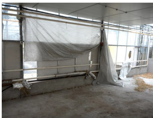
Foto 20. Niet-asbesthoudende plaatmateriaal (bron Bron5)
