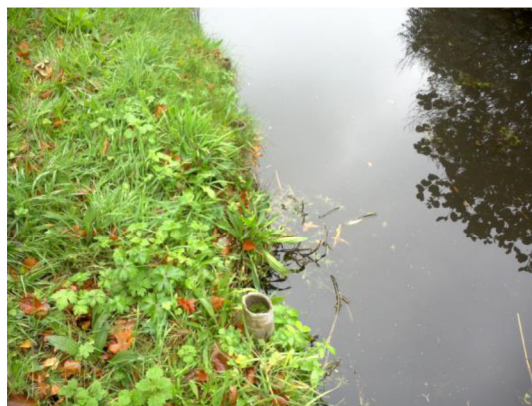
Foto 42. Asbesthoudende beschoeiing (bron Bron12)
