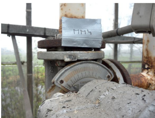
Foto 23. Niet-asbesthoudende flenspakking (bron Bron6)
