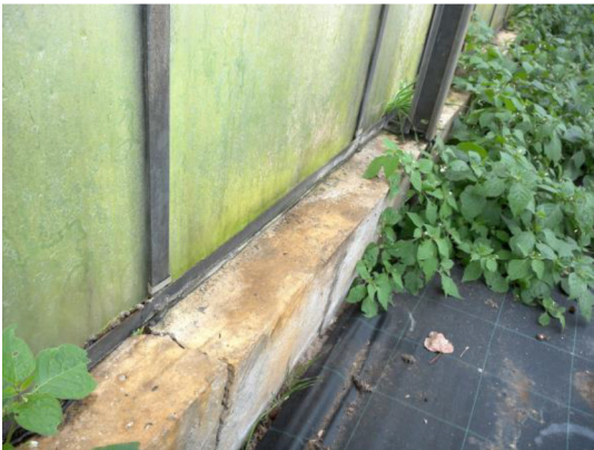
Foto 11. Asbesthoudende kaskit op voetrand (bron Bron3)
