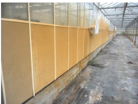
Foto 21. Niet-asbesthoudende plaatmateriaal (bron Bron5)
