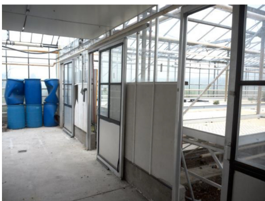
Foto 19. Niet-asbesthoudende plaatmateriaal (bron Bron5)
