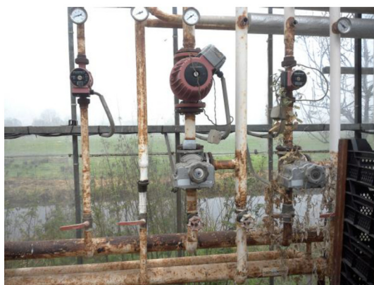
Foto 22. Niet-asbesthoudende flenspakking (bron Bron6)
