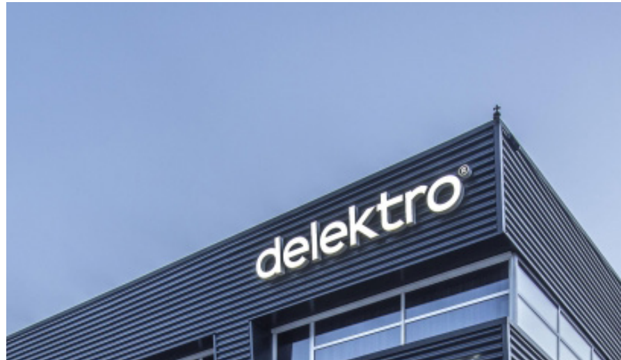
Referentiebeeld: reclame is uitgelijnd met de gevelindeling
