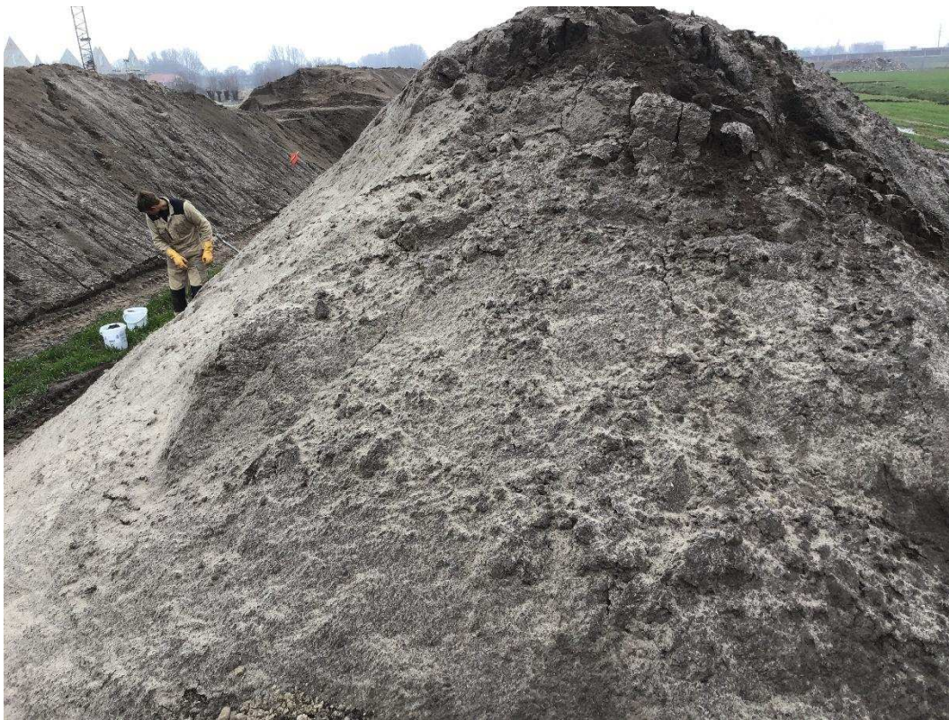
Depot B1 – Hoekpunt noordzijde
