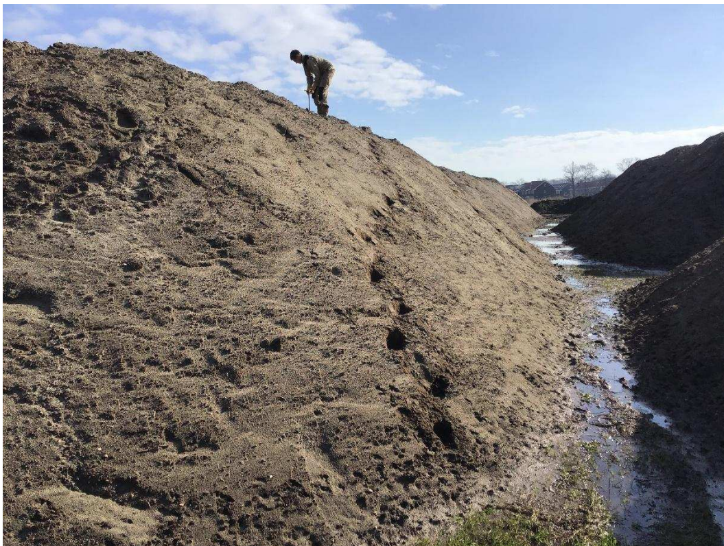
Depot A4 – Zuidzijde
