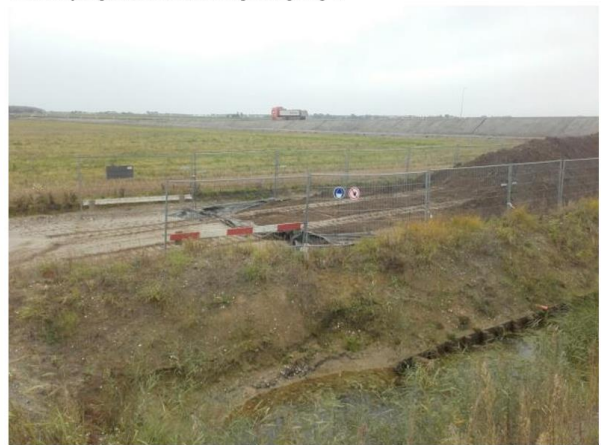
Fotonummer: 12 Omschrijving: Depot
