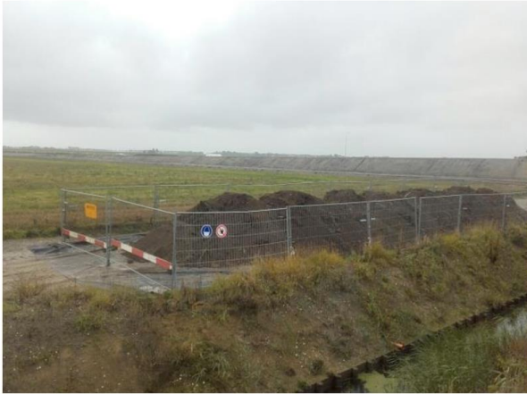
Fotonummer: 7 Omschrijving: Depot
