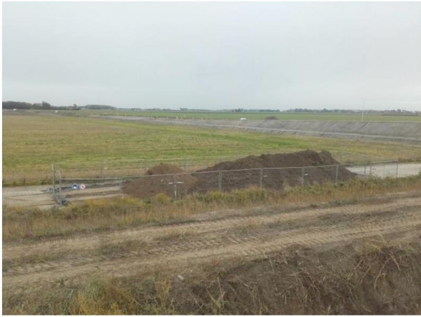
Fotonummer: 13 Omschrijving: Depot
