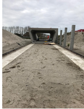
Fotonummer: 14 Omschrijving: Middels leeflaag afgedekte spot nabij fietstunnel
