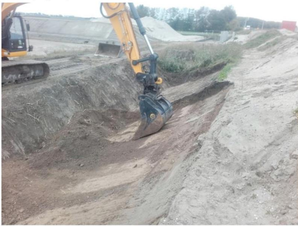
Fotonummer: 9 Omschrijving: Aanvullende ontgraving dag 2
