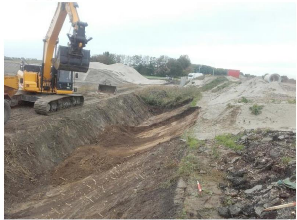
Fotonummer: 10 Omschrijving: Aanvullende ontgraving dag 2
