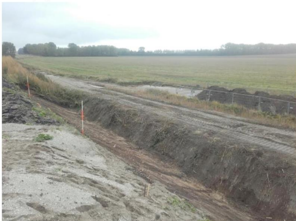
Fotonummer: 5 Omschrijving: Overzicht ontgraving en depot
