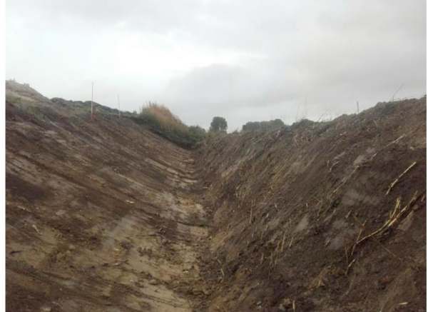
Fotonummer: 4 Omschrijving: Ontgraving talud
