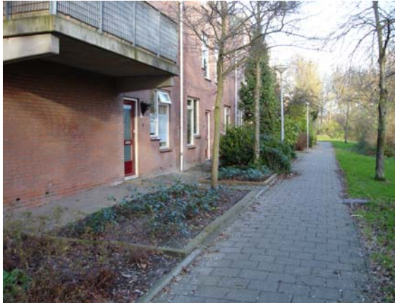
Figuur 14. Bomen te dicht op voorgevel
