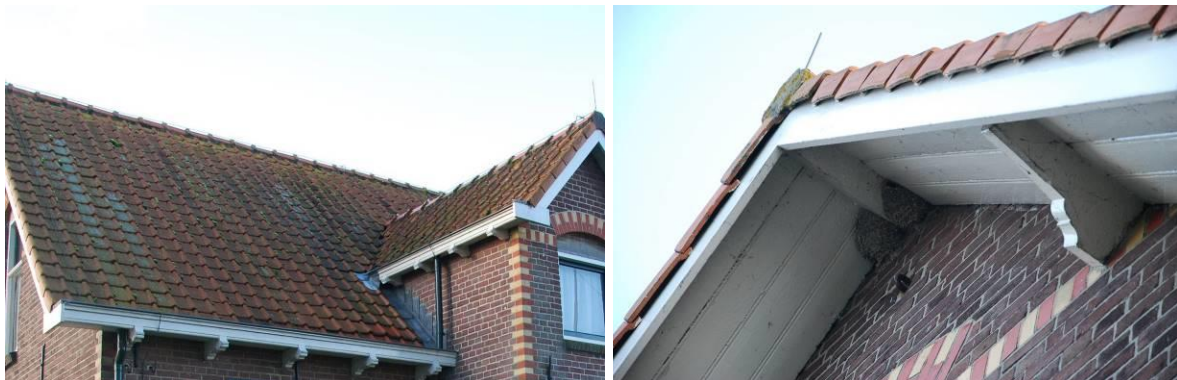
Figuur 5.1. Links: noordzijde van het dak met dakkapel. Rechts: twee huiszwaluwnesten.
