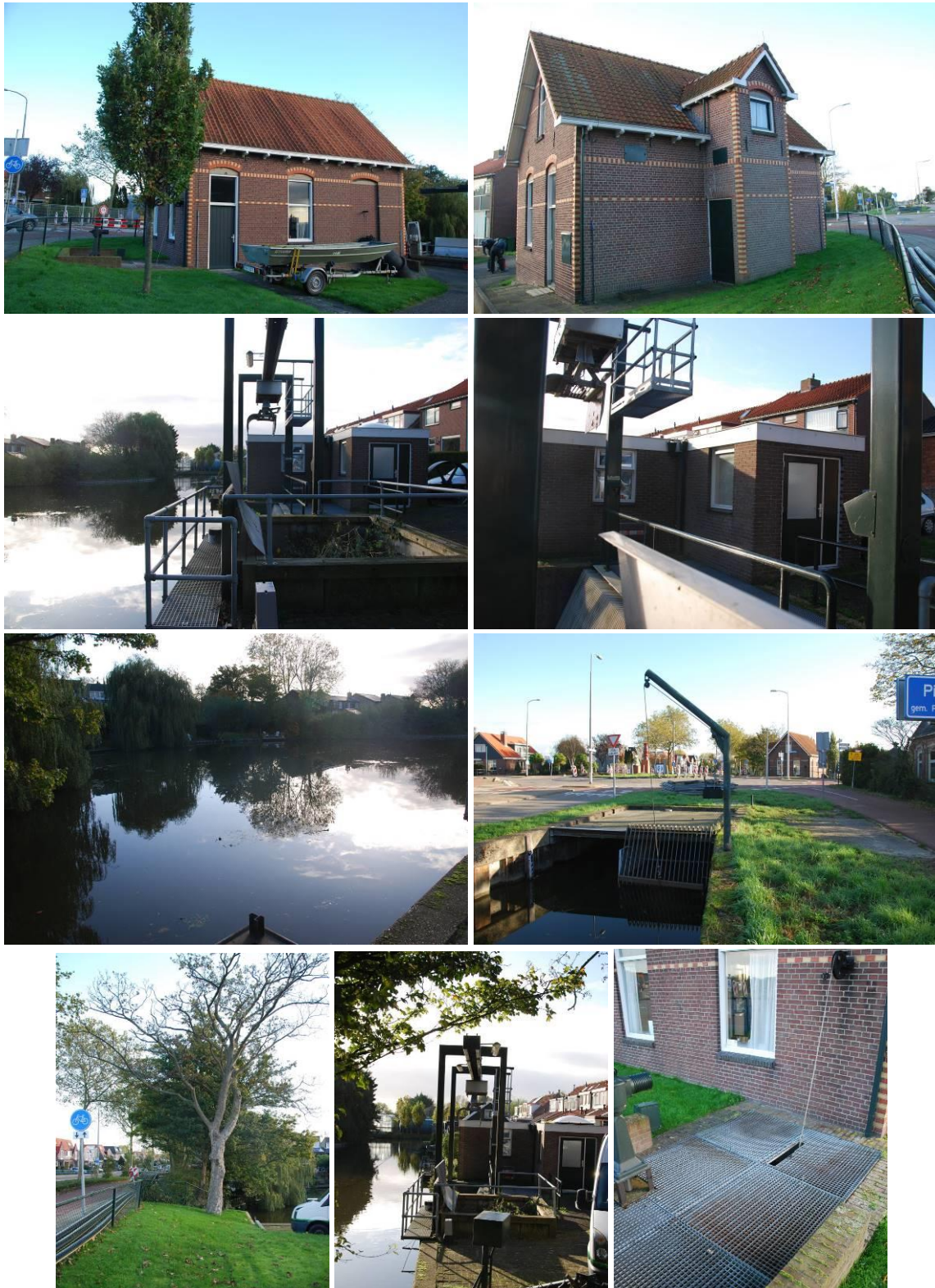
Figuur 3.2. Impressie van het plangebied. Boven: de gemaalwoning. Daaronder: gemaal en bijgebouw. Daaronder links: het water ten westen van het plangebied. rechts: de uitstroomput buiten plangebied. Linksonder: de esdoorn, midden: het gemaal, rechts: uitstroomput aangrenzend aan gemaalwoning.
