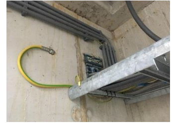
Aardingsysteem en doorvoer
