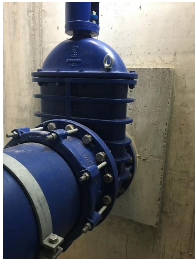
Afsluiter met stijgend spindel
