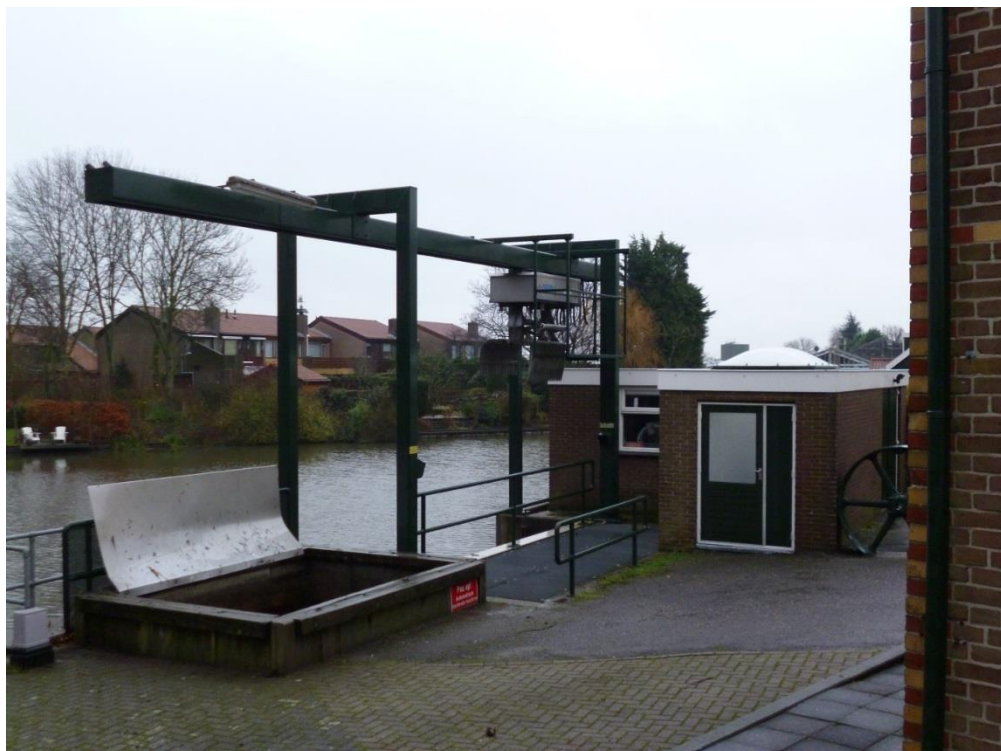
Bestaande reiniger in huidige opstelling
