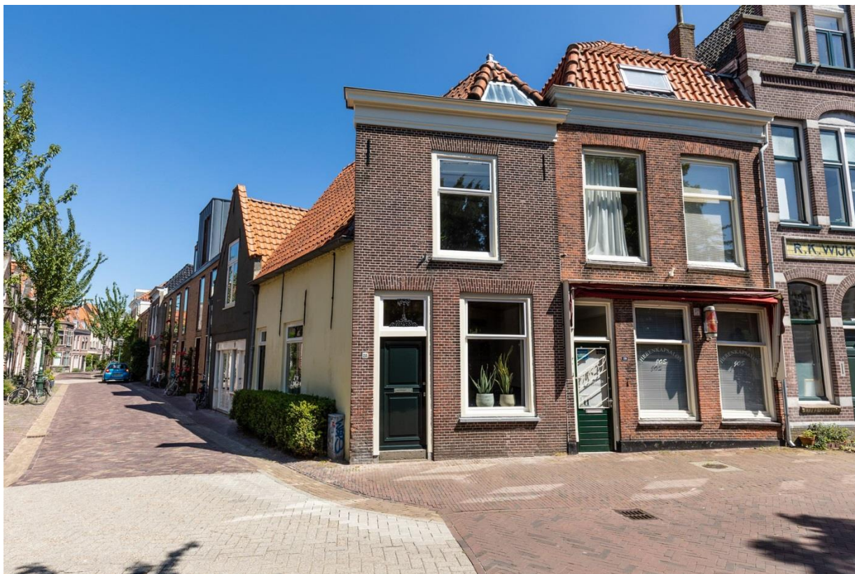
Voorgevels 1e Binnenvestgracht 28, 29 en deels 30. Linkerzijde gevels Narmstraat 44 en verder.
