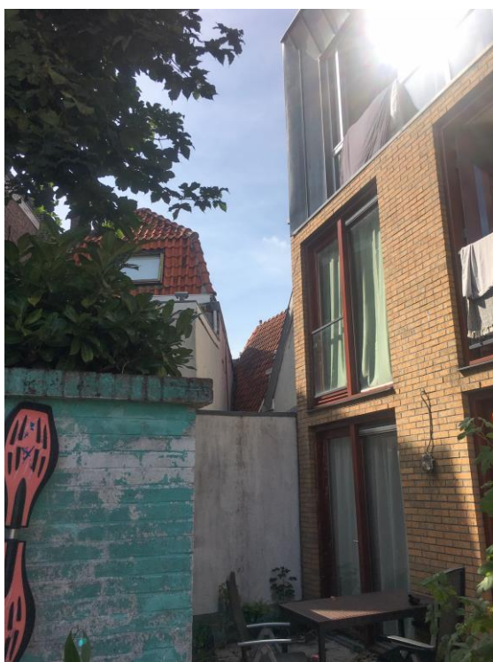
Het zicht op het dakvlak van nr.28 is beperkt.
