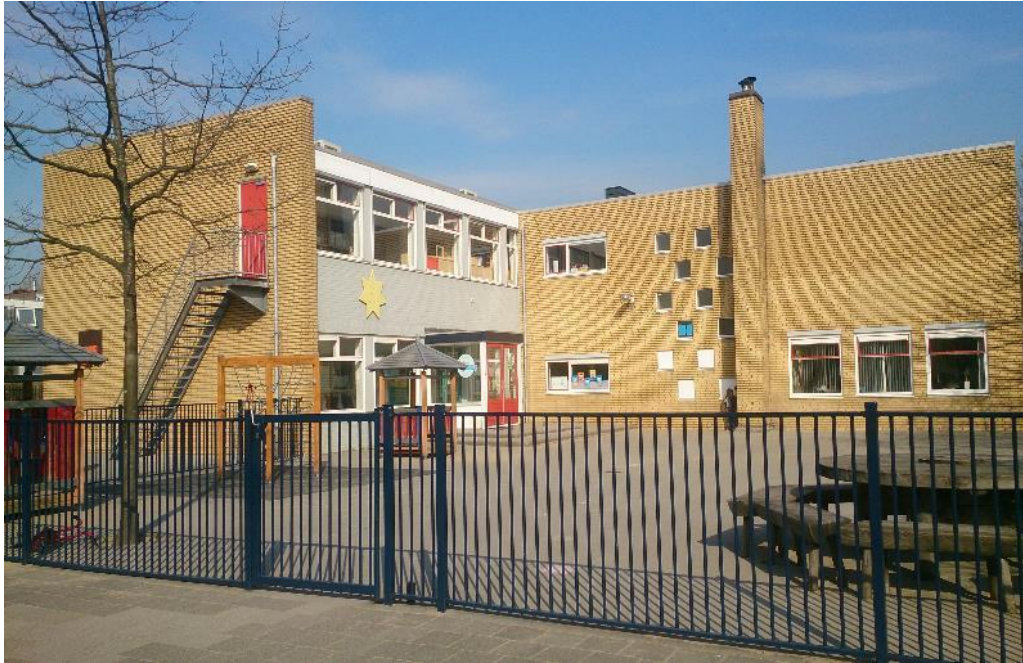
Figuur 1 Een van de schoolgebouwen (nummer 30, westzijde) van de Albert Schweitzer school aan de Jan Steenstraat 30 en 34 is opgetrokken uit gemetselde muren en een bitumen dak.
