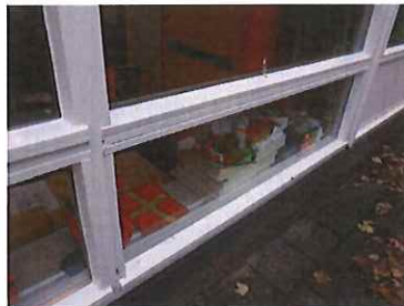
Foto 9: Partieel herstellen kozijn - rechtergevel.
