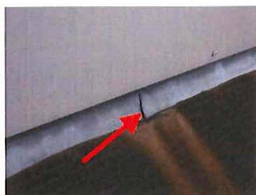
Foto 15: Vervangen loodslabben.
