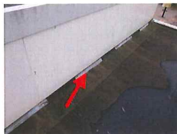
Foto 14: Vervangen loodslabben.
