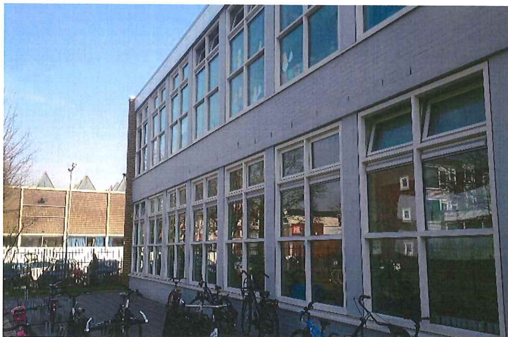
Figuur 2 Aan de achterkant van het schoolgebouw zijn een aantal openingen waargenomen, waar gebouw-bewonende vleermuizen mogelijk gebruik van kunnen maken.
