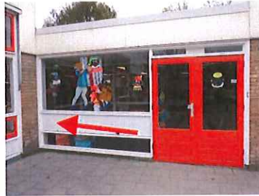
Foto 1: Vervangen glaslat en paneelvulling.
