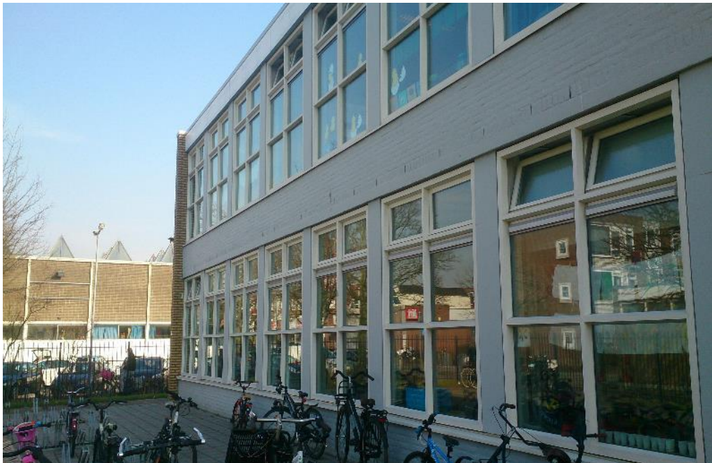
Figuur 2 Aan de achterkant van het schoolgebouw zijn een aantal openingen waargenomen, waar gebouw-bewonende vleermuizen mogelijk gebruik van kunnen maken.
