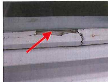
Foto 2: Vervangen glaslat en paneelvulling.
