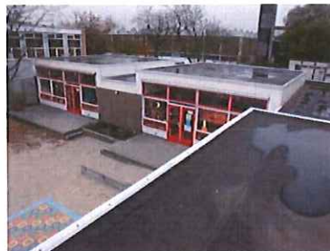
Foto 11: Vervangen dakbedekking.
