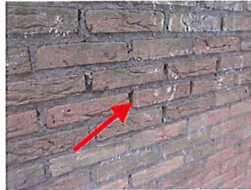
Foto 8: Partieel herstellen gevelvoegwerk linkergevel.
