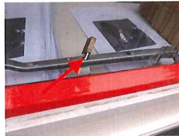
Foto 4: Partieel herstellen hang- en sluitwerk.
