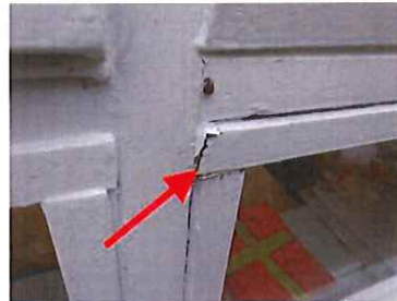
Foto 10: Partieel herstellen kozijn - rechtergevel.
