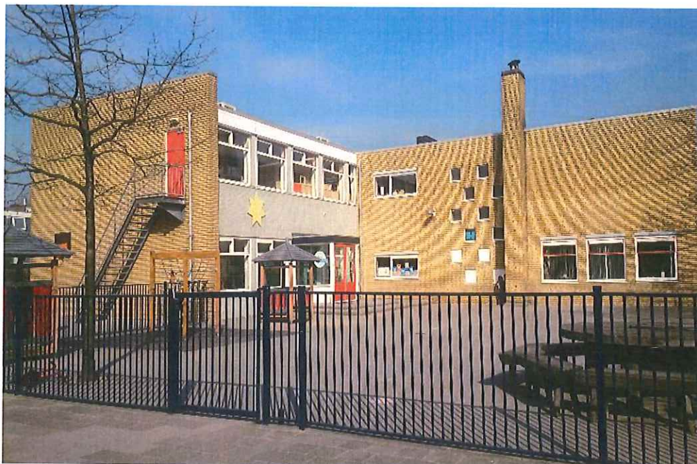
Figuur 1 Een van de schoolgebouwen (nummer 30, westzijde) van de Albert Schweitzer school aan de Jan Steenstraat 30 en 34 is opgetrokken uit gemetselde muren en een bitumen dak.
