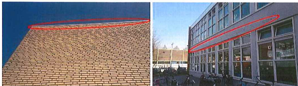
Figuur 2 In de bebouwing van de planlocatie zijn verschillende openingen aanwezig (rood omcirkeld).
