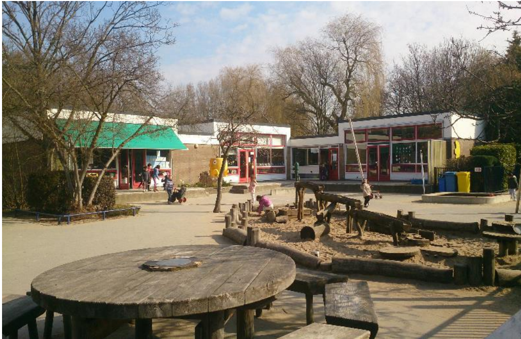
Figuur 3 Het andere schoolgebouw (nummer 34, oostzijde) is opgetrokken uit gemetselde muren en een bitumen dak.
