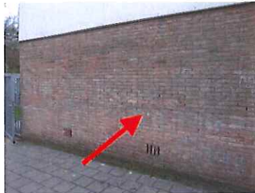
Foto 7: Partieel herstellen gevelvoegwerk linkergevel.
