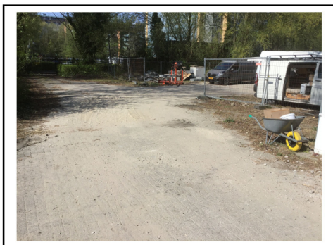
Zicht op het met klinkers verharde terreindeel. Rechts het bouwhek met hierachter de nieuwbouwlocatie.
