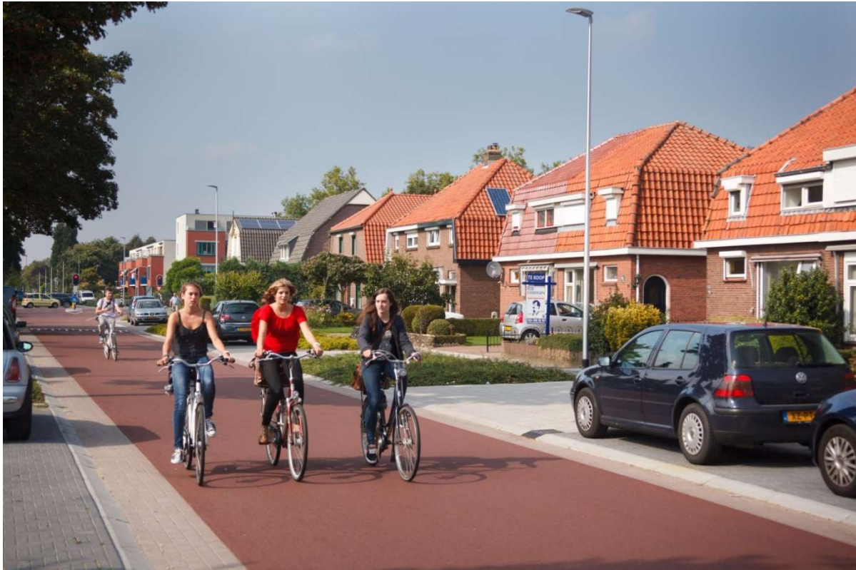
Voorbeeld van smalle fietsstraat met aanpalend verhoogde parkeervakken (Nijmegen) en materialisatie.
