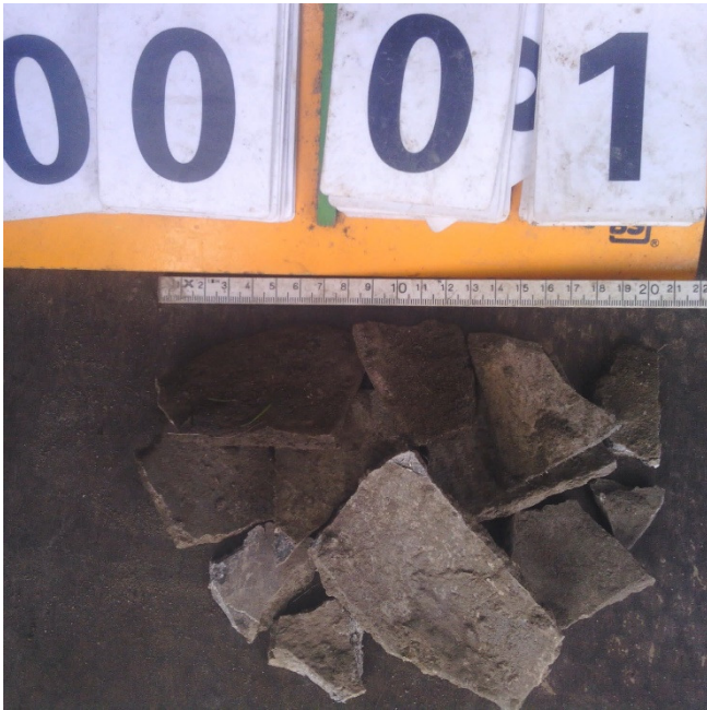
Asbestverdacht materiaal sleuf 01
