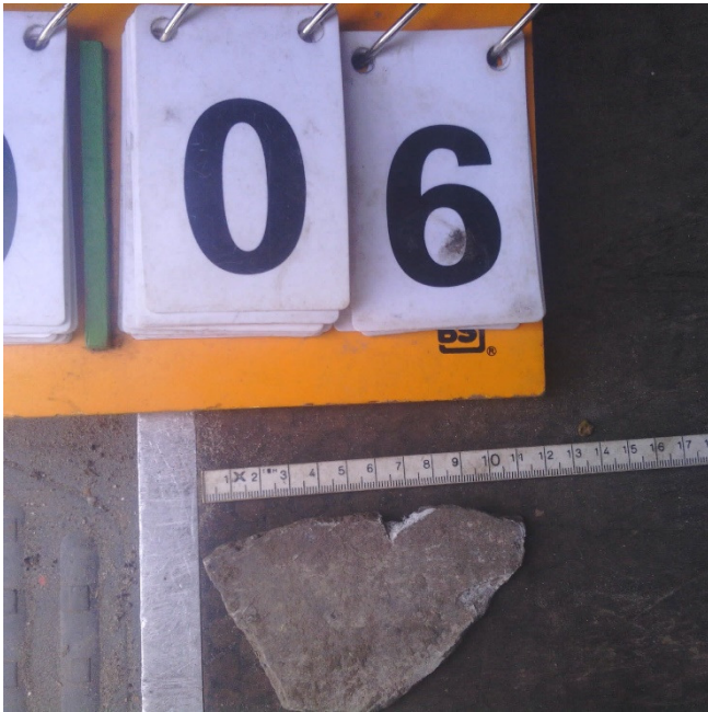
Foto asbestverdacht materiaal gat 06
