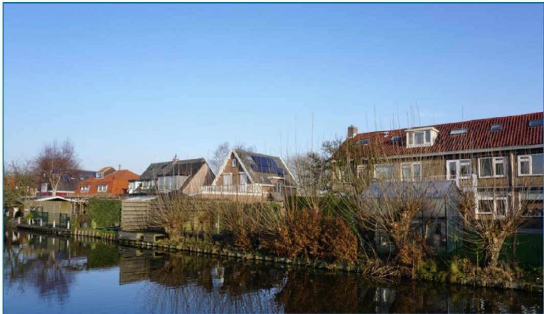
Afbeelding 2. Foto van bestaande kade beschoeiing in tracé zuid, gezien vanaf de Lookwatering (bron foto: Hoogheemraadschap van Delfland).
