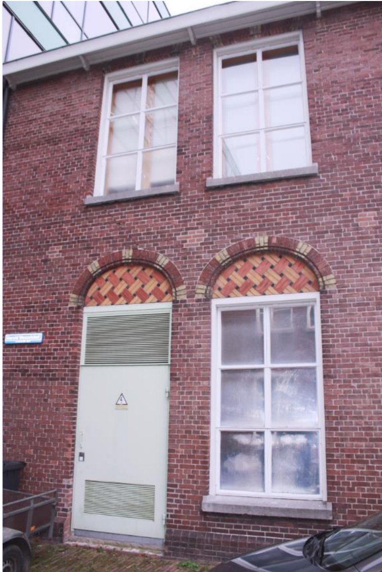
De opbouw van vensters in de zijgevels van de achtervleugels bestaat uit segmentbogen van oranje en gele verblendstenen op de begane grond en gemetselde strekken op de verdieping.
