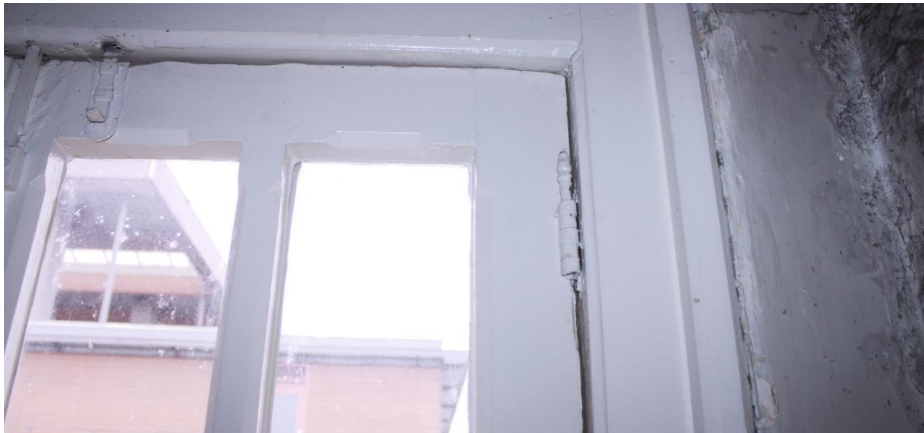
Het raam in het venster van de dakkapel boven de zuidelijke hoekrisaliet heeft nog het oorspronkelijke hangwerk.
