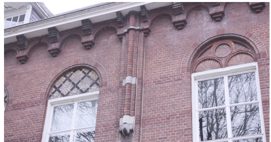
Detail van de bovenzijde van een pilasters met halfzuil.
