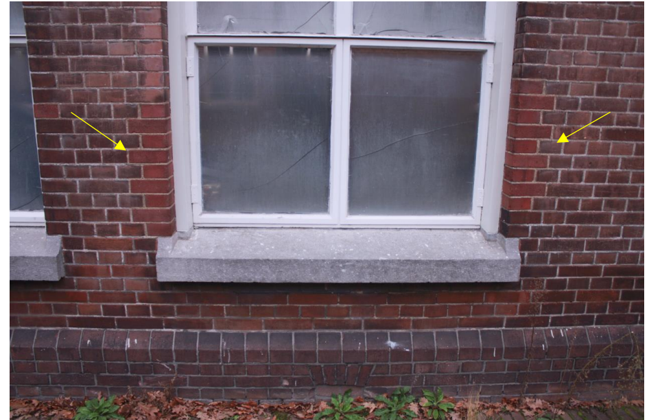
Detail van de later aangebracht raampartijen in de zijgevels van een van de achtervleugels. Bij het aanbrengen van het huidige kozijn is het muurwerk hersteld.
