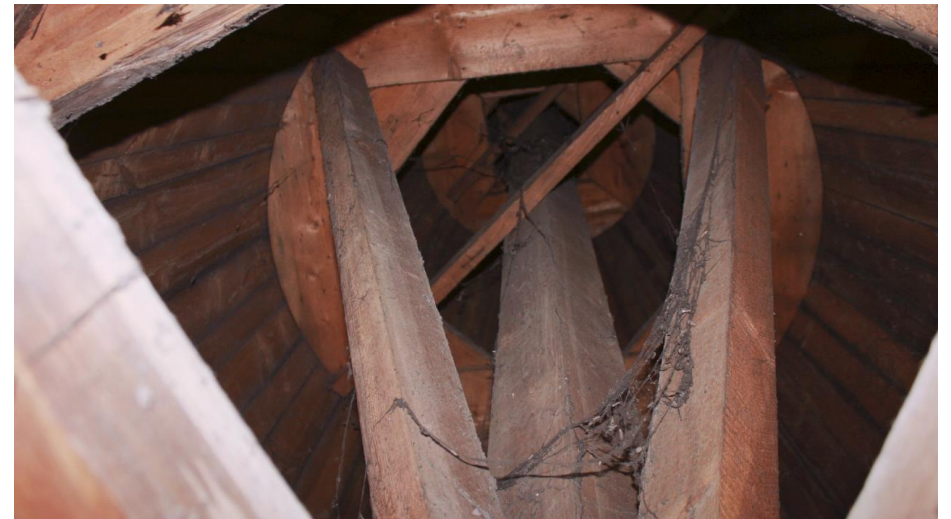
Detail van de geschoorde makelaar in de kap van de torenspits.
