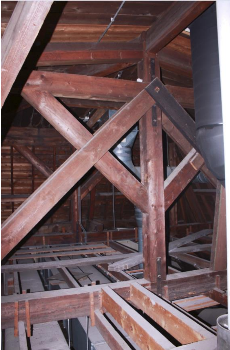
Detail van het gestapelde stijlenpaar met middenstijl boven de middenrisaliet.
