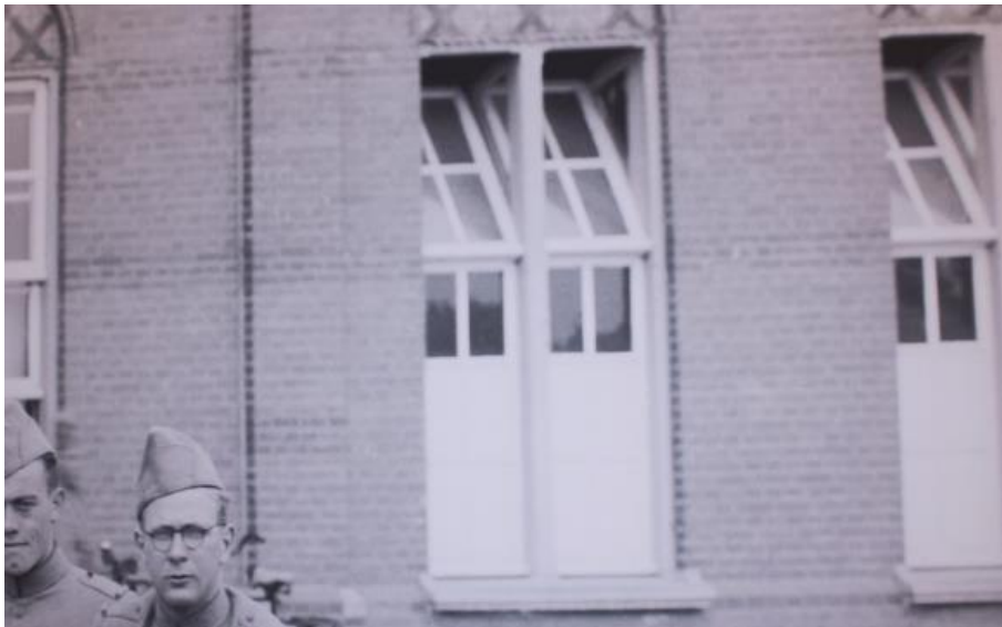
Detail van een foto uit 1939, genomen aan de voorzijde van de kazerne. De vensters in de geveldelen tussen de risalieten hadden de begane grond klapbare bovenlichten. GAB.
