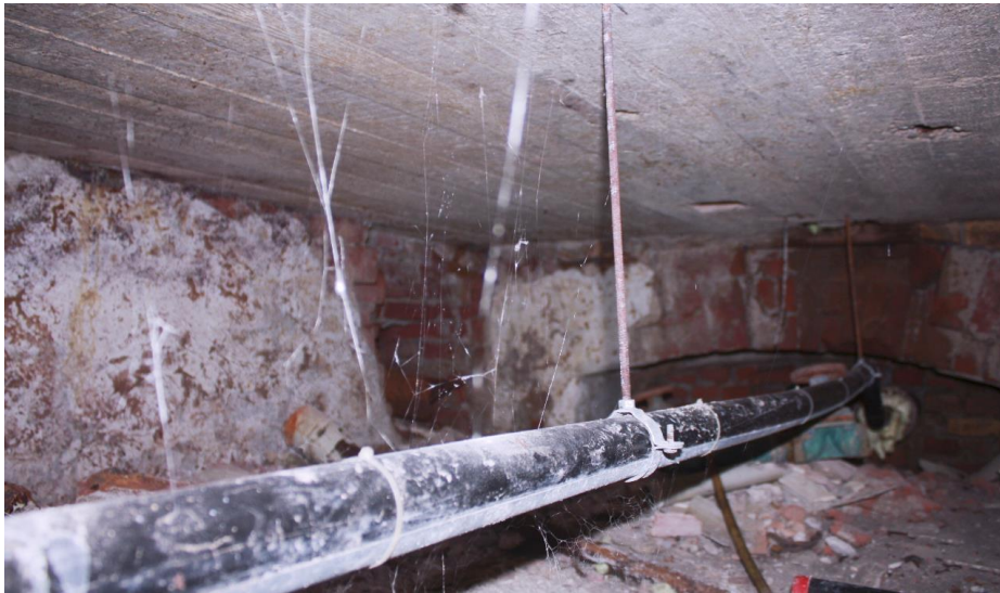
Een nieuwe betonvloer met kruipruimte op de begane grond van een van de achternvleugels.
