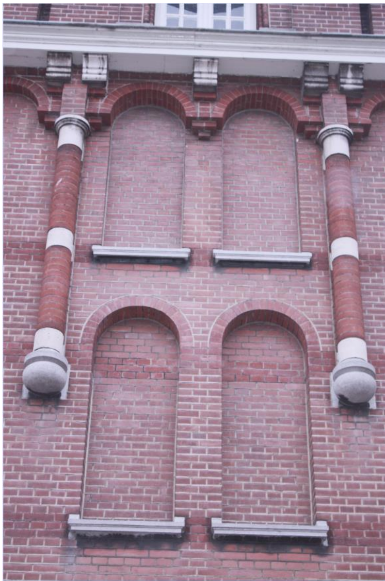
Detail van de rondboognissen en halfzuilen in het middelste deel aan de zijkant van de noordelijke hoekrisaliet.
