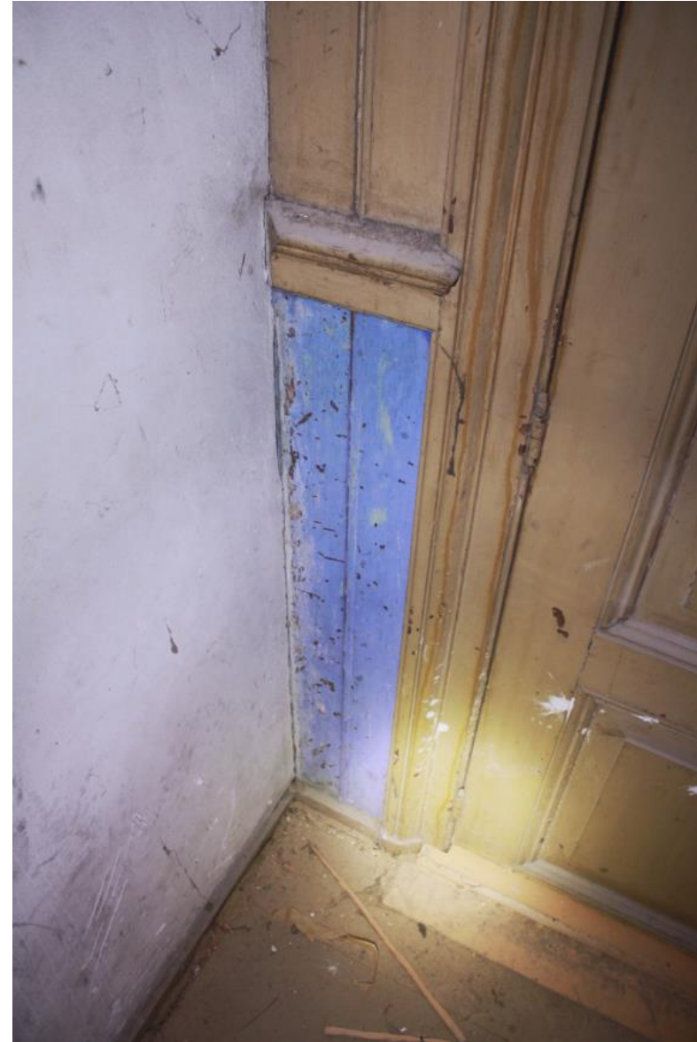
Detail van de kobaltblauwe kleur op de schroten in de hal op de zolder van de noordelijke hoekrisaliet.
