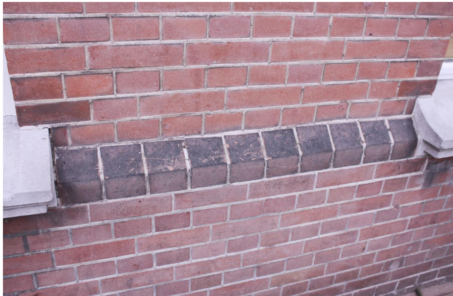
Detail van het muurwerk ter plaatse van de zijgevel van de achtervleugel, ter hoogte van de plint.
