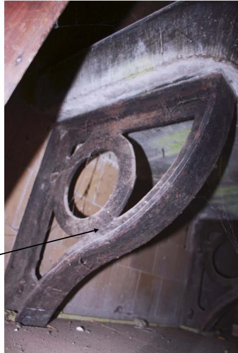
Detail van de smeedijzeren beugel die de wastafel draagt.
