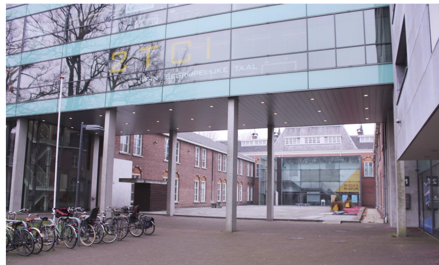
Zicht vanaf de Keizerstraat op de achtergevel van de hoofdvleugel, ter hoogte van de middenrisaliet, thans een doorgang vanuit het Breda's Museum naar de achterzijde van het gebouw. De gevel is verscholen komen te liggen achter de nieuwbouw aan de Keizerstraat.
