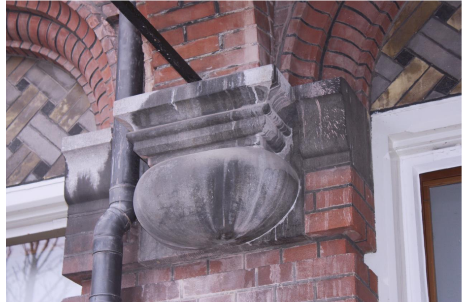
Hardstenen console bij de scheiboog aan weersinden van de galerij.
