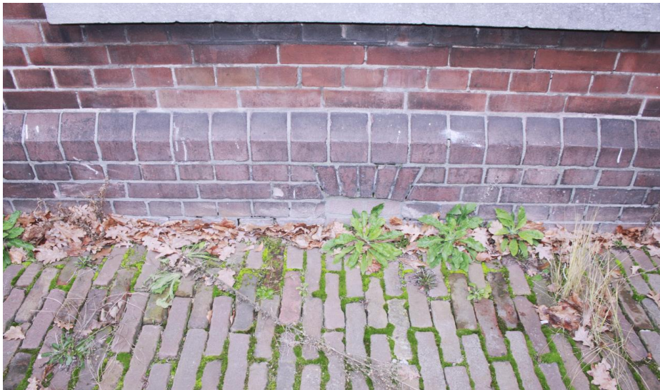
In de zijgevel van de achtervleugels zijn de oorspronkelijke posities van de ventilatieroosters nog zichtbaar.
