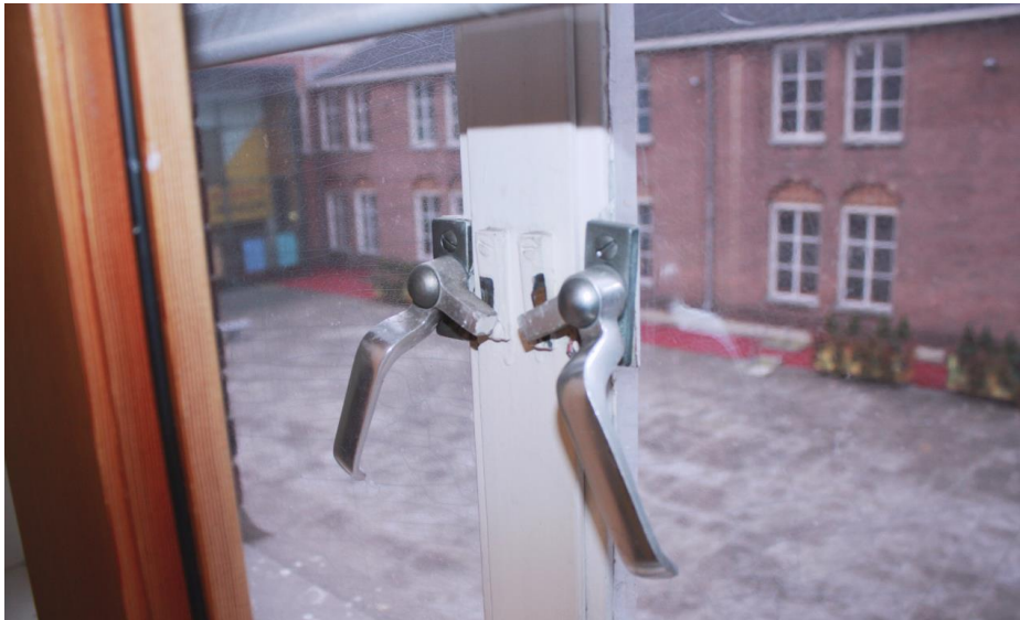
Detail van het sluitwerk van een stalen raampartij op de verdieping van een van de achtervleugels.
