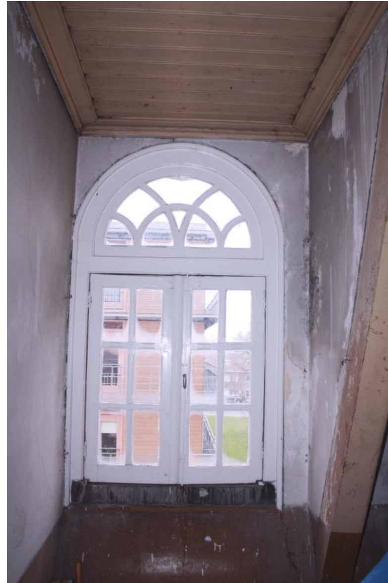
Het oorspronkelijke venster met raam en halfrond bovenlicht in de dakkapel boven de zuidelijke hoekrisaliet.
