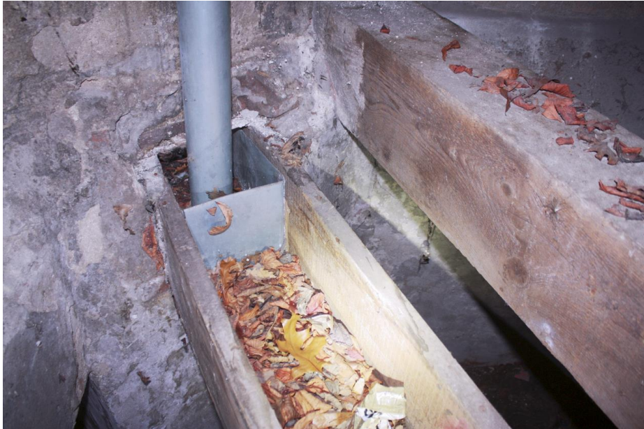
Detail van de houten Keulse goot in de rechter hoektoren.
