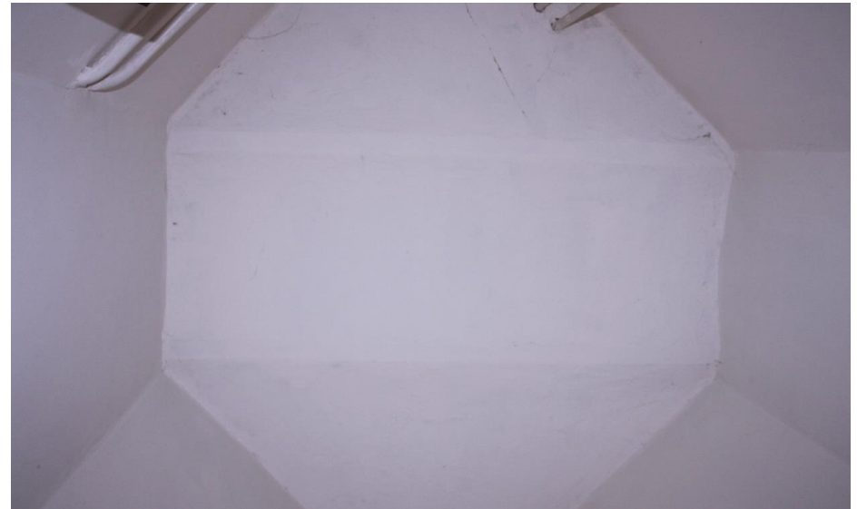
Detail van het troggewelf boven de begane grond van de hoektoren.
