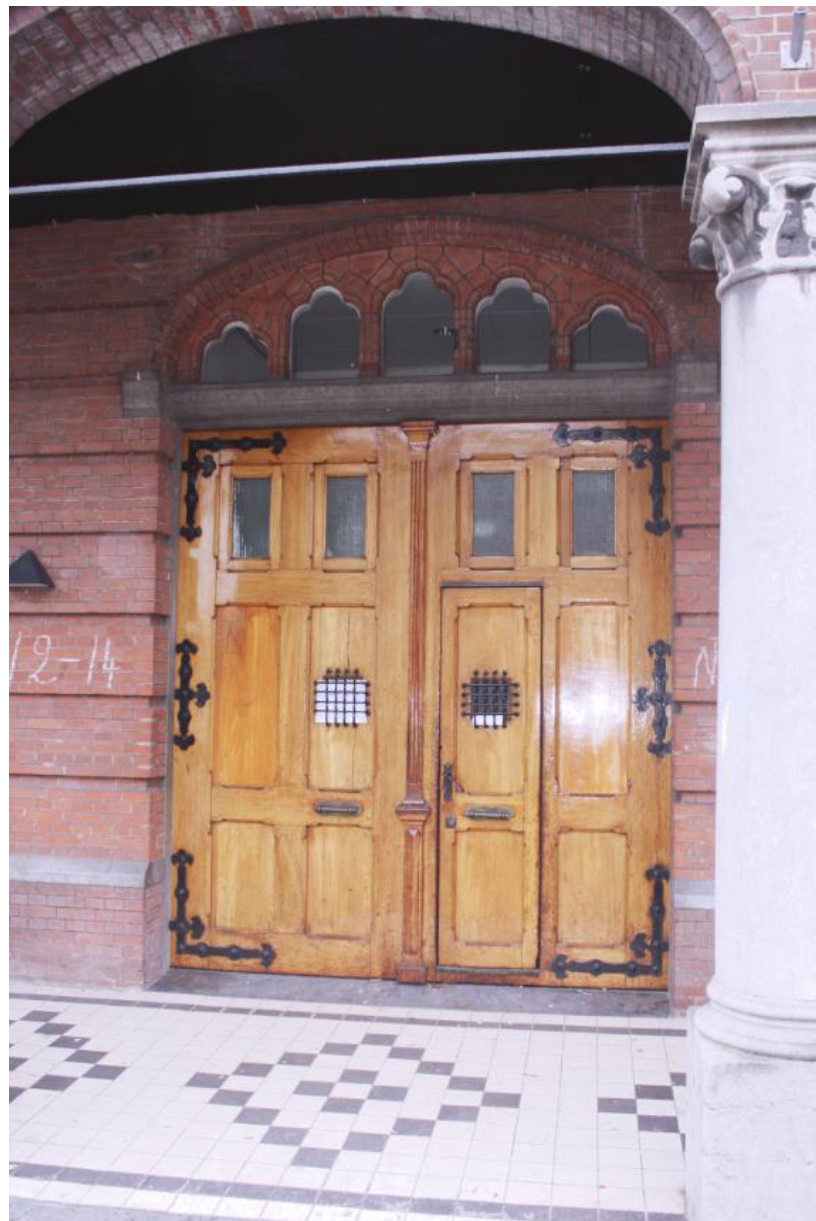
Detail van de hoofdentree in de galerij, met tegelvloer en houten paneeldeuren met smeedijzeren hang- en hekwerk. De rechter deur is deelbaar.
