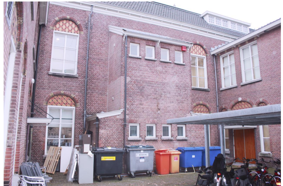
De uitbouw tegen de achtergevel van de voorvleugel, tussen twee achtervleugels in. De vier vensters zijn oorspronkelijk. De oorspronkelijke rondvensters aan de kopse kanten van de uitbouw zijn verwijderd.
