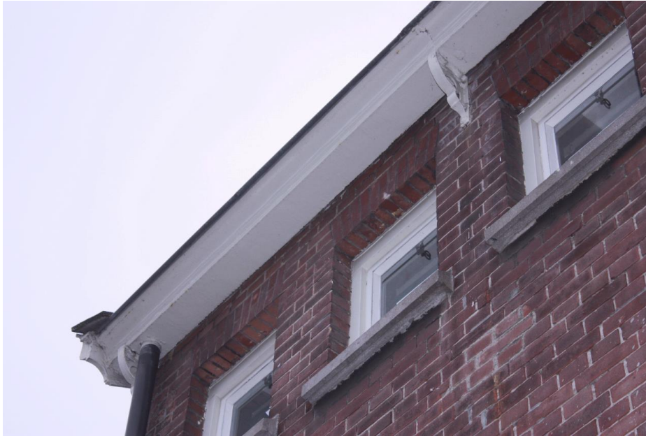
Detail van de smeedijzeren beugels die de bakgoot van de uitbouw aan de achterzijde van de voorvleugel dragen. De ramen in de uitbouw kunnen origineel zijn.
