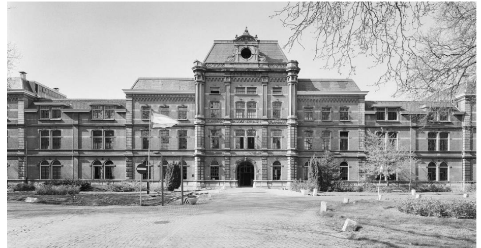
De in 1990 gesloopte Utrechtse Hojel-kazerne uit 1888 is wat de architectuur betreft sterk beïnvloed door de Haarlemse Ripperdakazerne. Foto Beeldbank RCE
