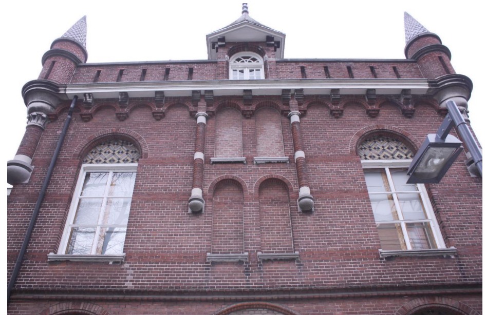
Het muurwerk aan de zijkant van de noordelijke hoekrisaliet is uitgevoerd met banden in verblendstenen. De goot wordt gedragen door consoles die in een gemetselde boogfries zijn aangebracht.
