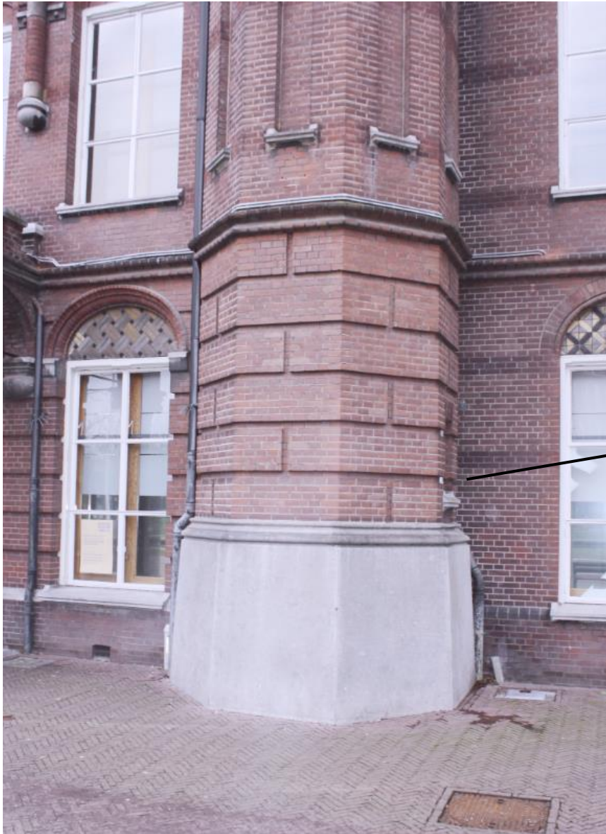
Detail van de voet van de rechter hoektoren, met een hardstenen plint en daarboven imitatie rustica in schoon metselwerk.
