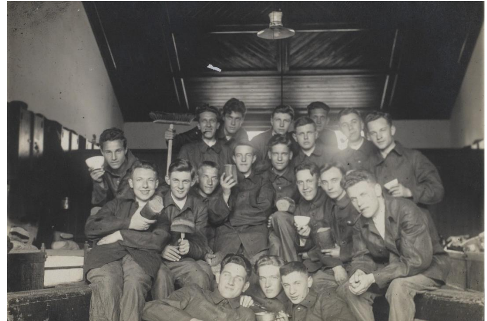
Het interieur van de achtervleugel op de verdieping, hier zichtbaar op een foto uit 1925, was simpel uitgevoerd. De ruimtes lagen onder de dakconstructie van gordingen, die betimmerd was met houten schroten. GAB 20150001.
