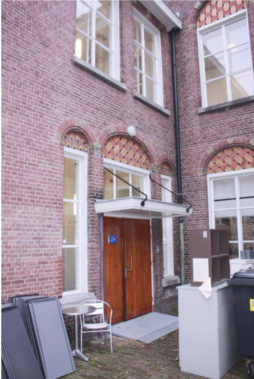
Een van de entree in het voorste travée van achtervleugels. Vermoedelijk zijn deze entrees, inclusief de hangende luifels, aangebracht omstreeks 1960.
