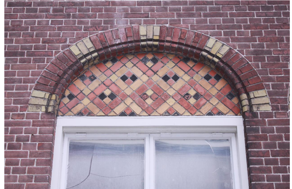
Detail van een met profielstenen uitgevoerde trommelboog met siermetselwerk boven een van de vensters in de achtergevel.
