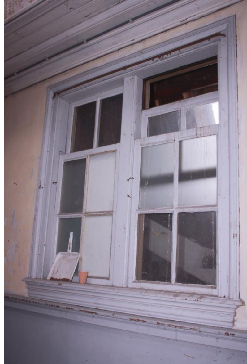
Het binnenvenster in de wand van het leslokaal op de zolder van de zuidelijke hoekrisaliet heeft een geprofileerde architraaflijst aan de onderzijde van de onderdorpel.
