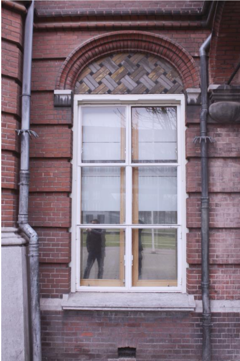
Een oorspronkelijk kozijn in de voorgevel. De ramen zijn later aangebracht.
