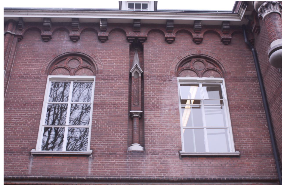
Detail van een nis op de verdieping in de geveldelen tussen de risalieten. De boogtrommels boven de vensters zijn gevuld met gemetselde driepassen in verblendstenen.
