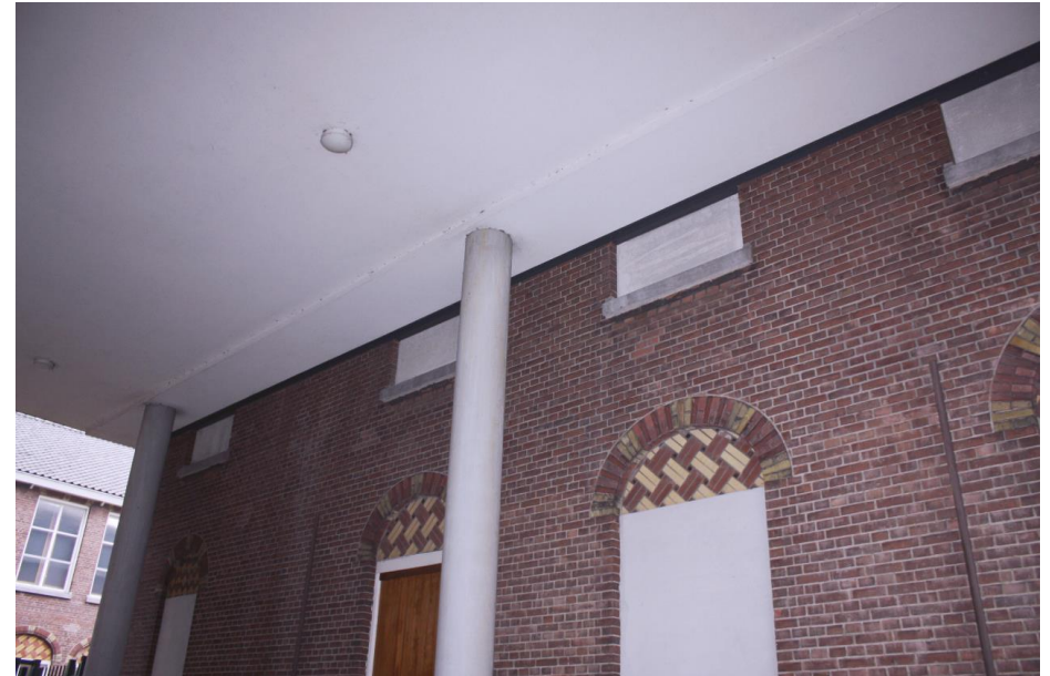
De vensters in de achtergevels van de achtervleugels zijn, waar zichtbaar, dichtgezet.
