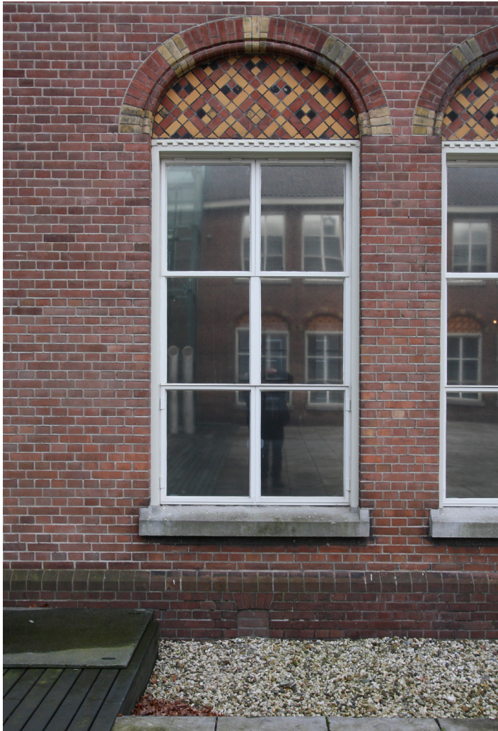
het onderzochte venster in de vleugel
