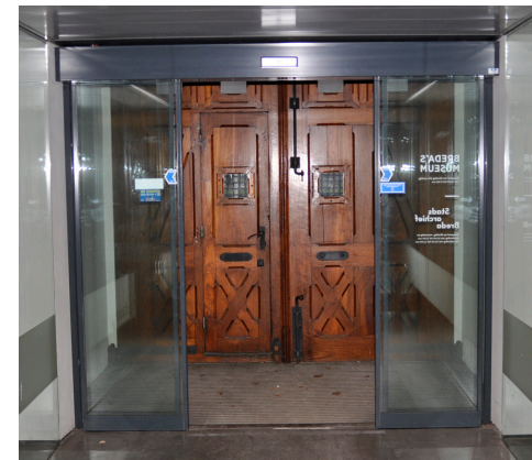
Herstel monumentale voordeur en sloop tochtportaal
